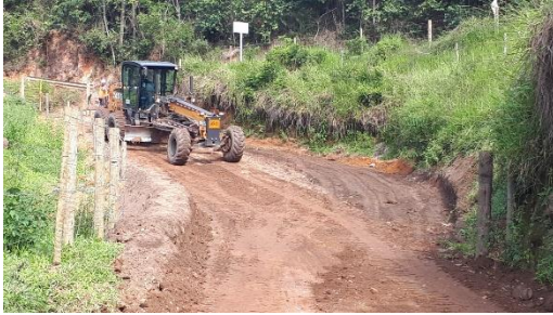
3c. Realização de acabamento na pista regularizada.
