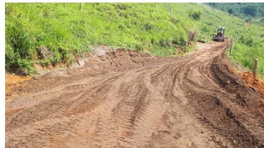
3b. Material retirado do rio sendo aplicado no acesso.
