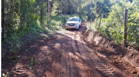
Atividades de regularização concluídas de uma das viagens aplicadas no acesso da propriedade Sítio Carvoeiro.
