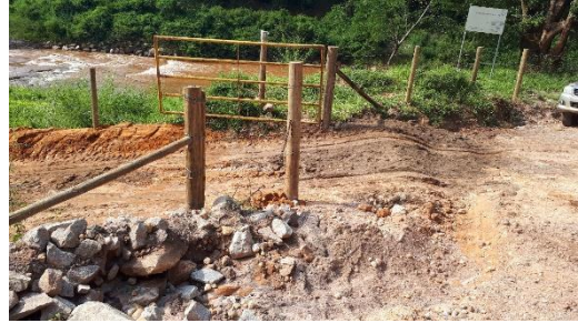
3d. Detalhe de drenagem instalada na entrada do acesso, data: 05/04/2019, hora: 14:18.
