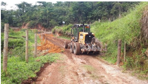
3a. Reparos realizados no acesso da Fazenda Ponte do Gama, com regularização do piso e instalação de uma leira de proteção do talude.
