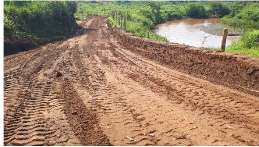
3e. Detalhe da leira instalada e da drenagem da pista que leva a água para outro ponto de drenagem mais à jusante.
