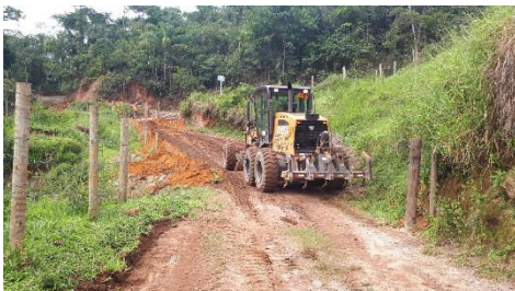
Reparos realizados no acesso da Fazenda Ponte do Gama, com regularização do piso e instalação de uma leira de proteção do talude.
