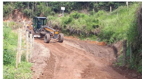
Realização de acabamento na pista regularizada.
