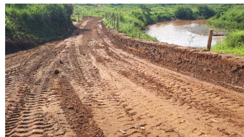
Detalhe da leira instalada e da drenagem da pista.
