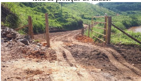
Visão geral de acesso mantido com drenagens, instalação de leira de proteção do talude e aplicação de material removido da calha do rio no próprio acesso.
