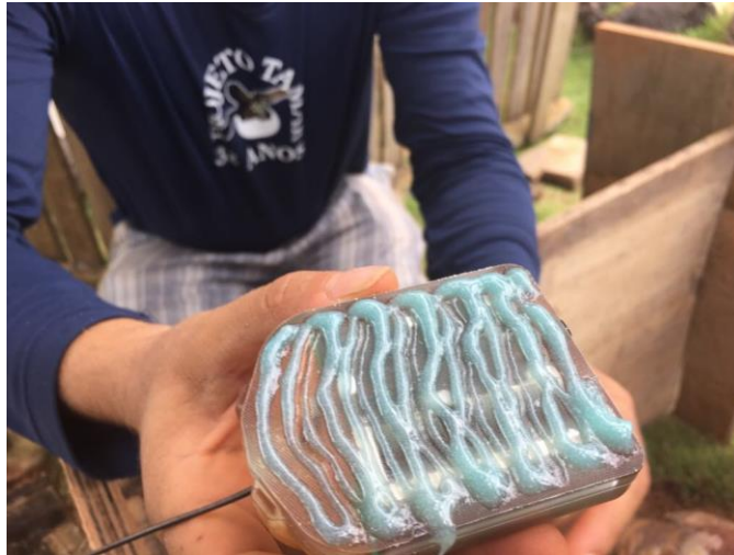
Aplicação do adesivo acrílico na parte inferior do transmissor
