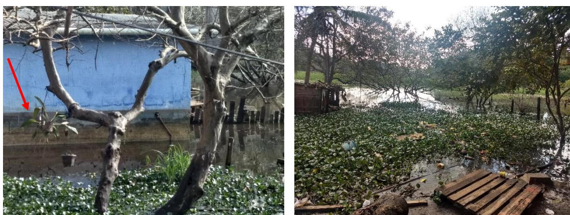
Figura 9: Detalhe da marca d'água em casa (à esquerda) e quintal inundado de outra residência (à direita)
