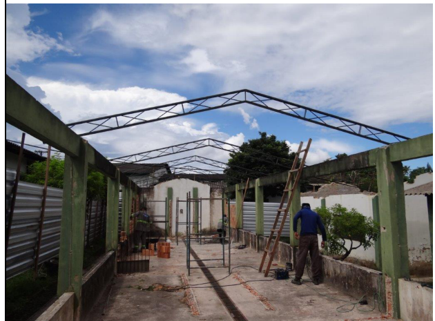
Colocação das estruturas metálicas
