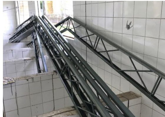
Preparação de novas estruturas metálicas
