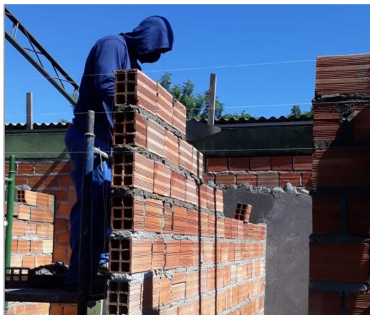
Início da alvenaria
