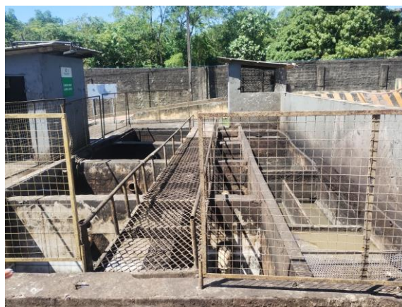
Fig. 14 – Setor de lavagem - sistema de separação de sobrenadante
