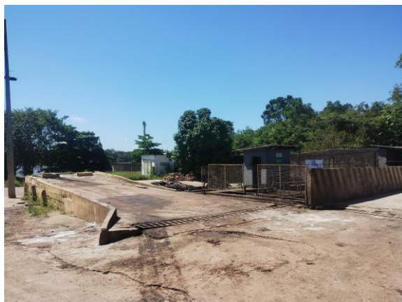
Fig. 13 – Setor de lavagem - local de lavagem do cutting box vazio
