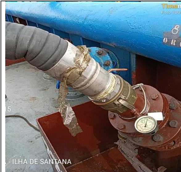
Engate do mangote do recolhedor no tanque
