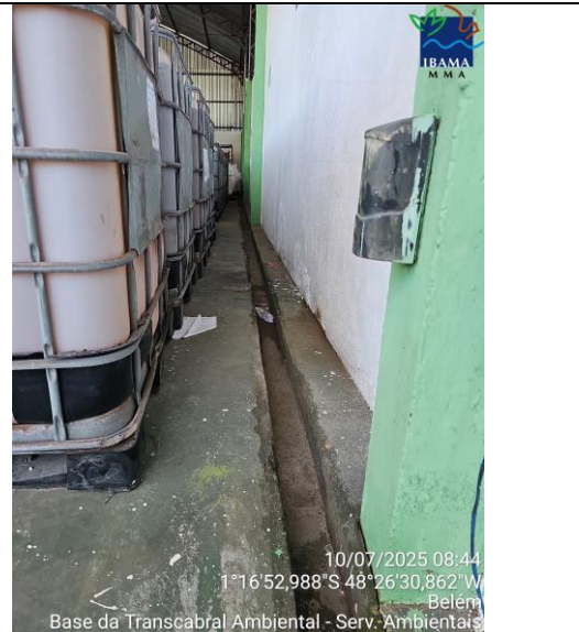
Contenção da área de armazenamento
