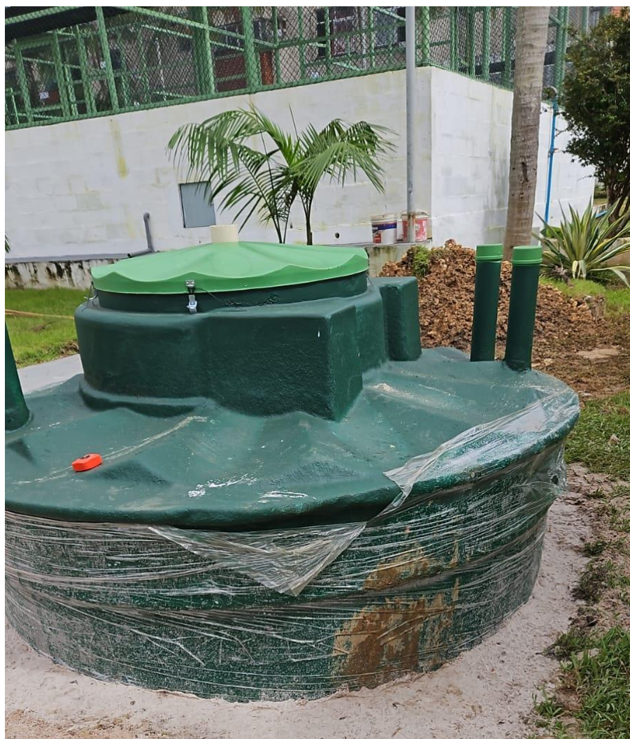
Figura 2 – Processo de instalação da ETE.
