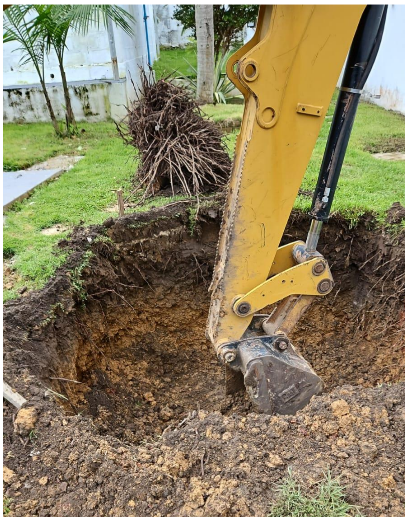
Figura 1 – Processo de instalação da ETE
