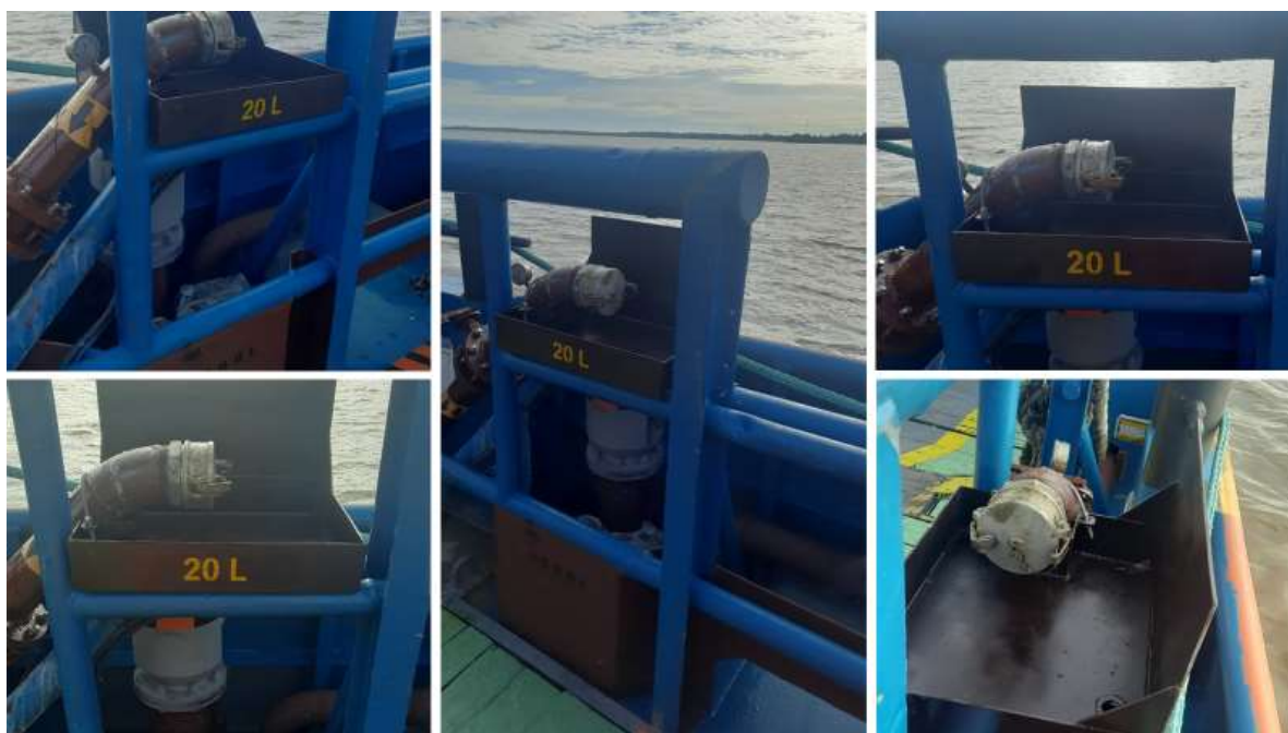
Figura 3 - Fotos em diversas perspectivas da bandeja confeccionada para recolhimento de eventuais derramamentos na tomada de abastecimento da embarcação Ilha das Flechas.
