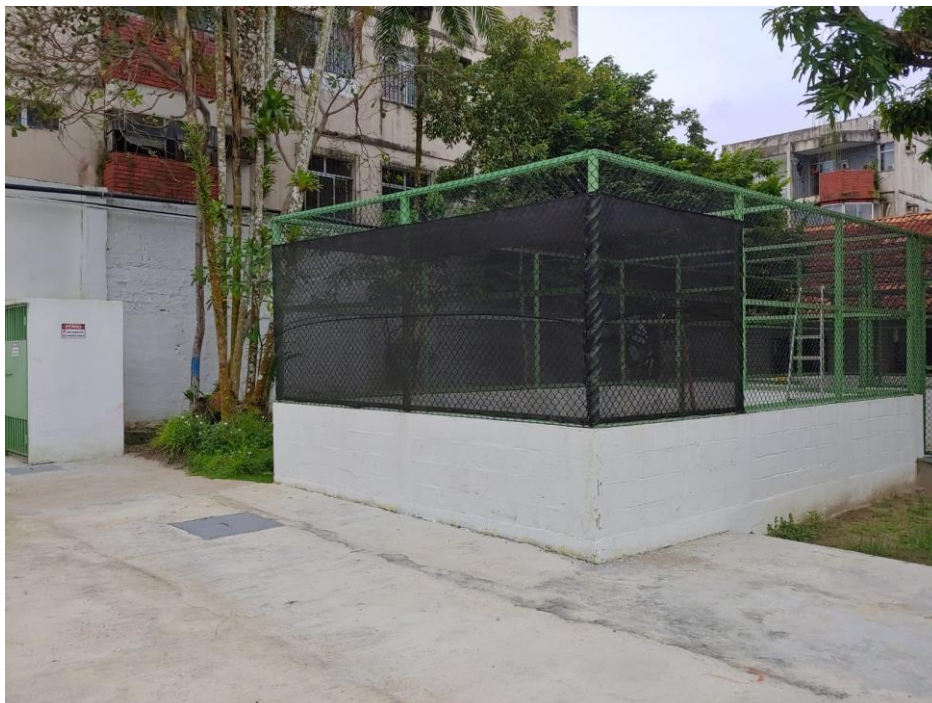
Figura 1 – Sombrite instalado na lateral do recinto para ampliação do sombreamento
