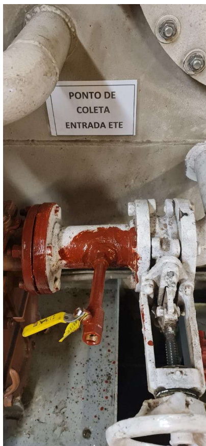
Figura 3: Ponto de coleta de amostra do sistema de tratamento de esgoto.
