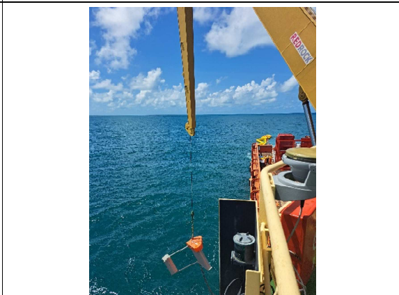
Foto 27: Lançamento do boomvane no mar
