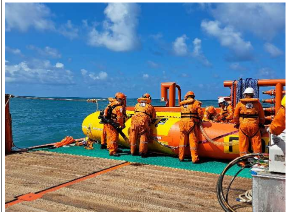
Foto 07: Inflamento da pump area da barreira
