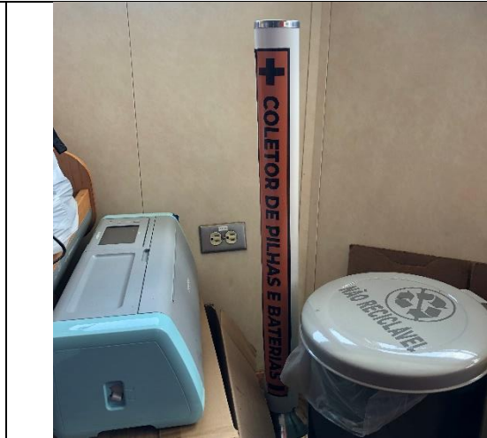
Foto 13: Coletor de pilhas e baterias
