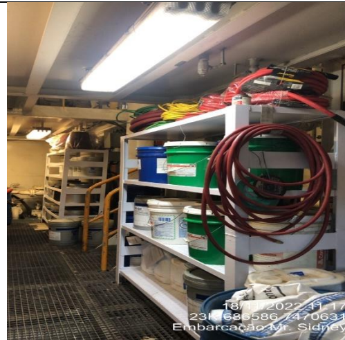
Foto 20: Futuro armazenamento de químicos
