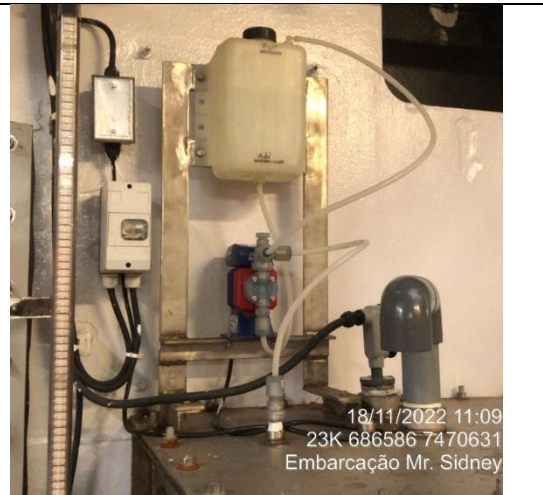
Foto 24: Estação de Tratamento de esgoto
