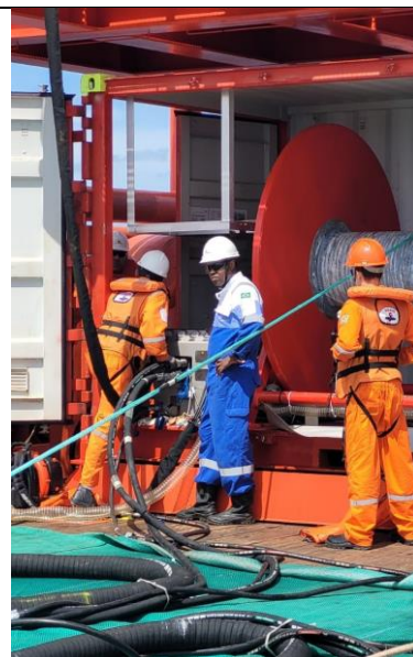
Foto 36: Mangote se desconectou do recolhedor no 1° teste - 2° dia 22.11.22
