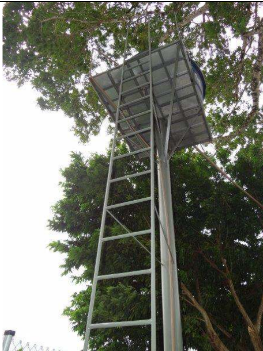
Escada de Acesso à Caixa d'água de 2.000 Lts.
