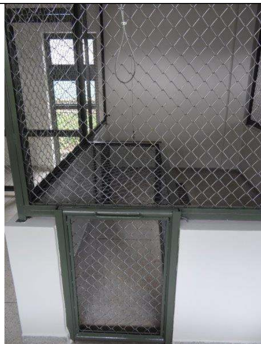
Portão ao fundo de acesso a area de cambamento, no Bloco #1.
