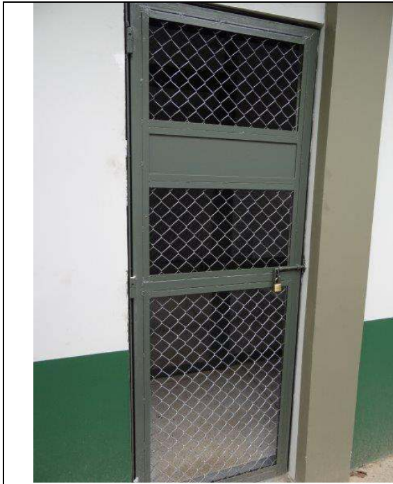
Portão ao fundo de acesso a area de cambejamento, no Bloco #1.
