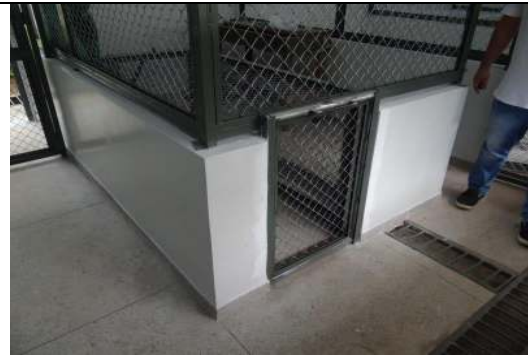
Area de cambamento no Bloco #1.
