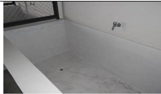
Tanques (2) para Limpeza/remoção de contaminação, na area de cambamento do Bloco #1
