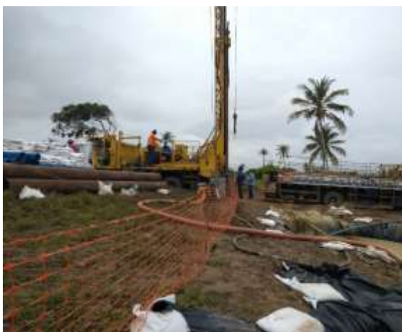
Figura 6 – Serviço de perfuração em Degredo no dia 30 de novembro de 2019.
