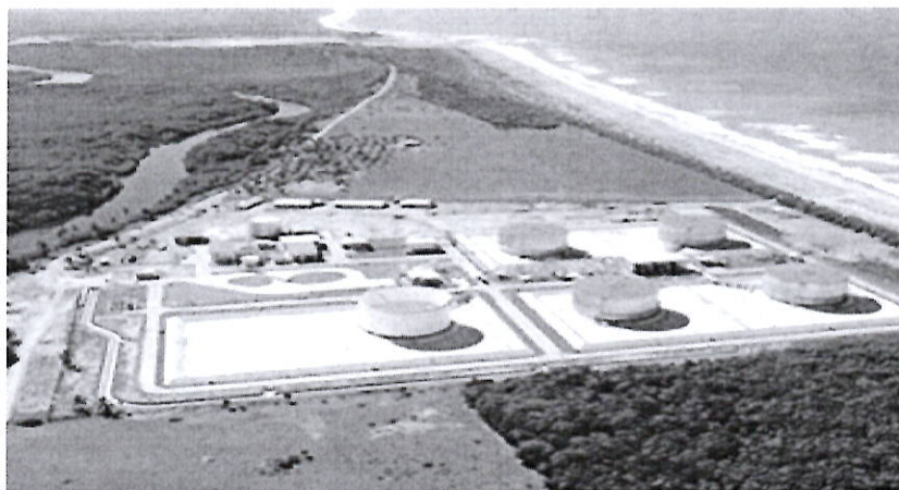
Figura 21: Vista aérea do Terminal Norte Capixaba, empreendimento da Transpetro/Petrobrás, na Localidade de Campo Grande de Barra Nova, instalado entre o mar e o rio/manguezal. Fonte: http://www.folhavoria.com.br/economia/noticia/2012/05
