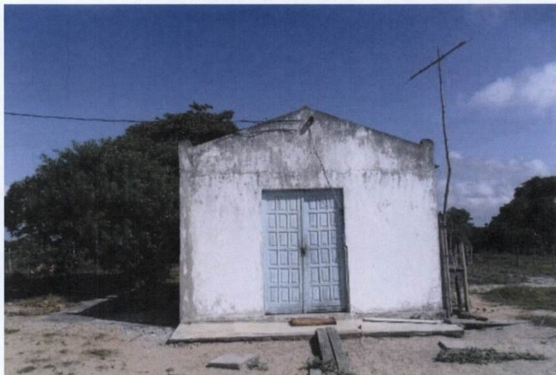
FOTO 46. Igreja de Nossa Senhora Aparecida
