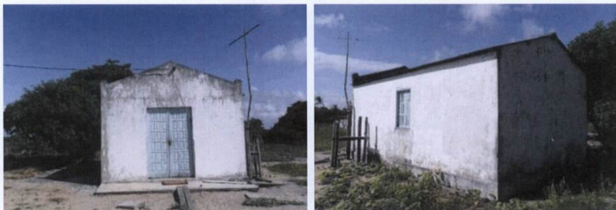
FOTO 65. Igreja de Nossa Senhora Aparecida.
