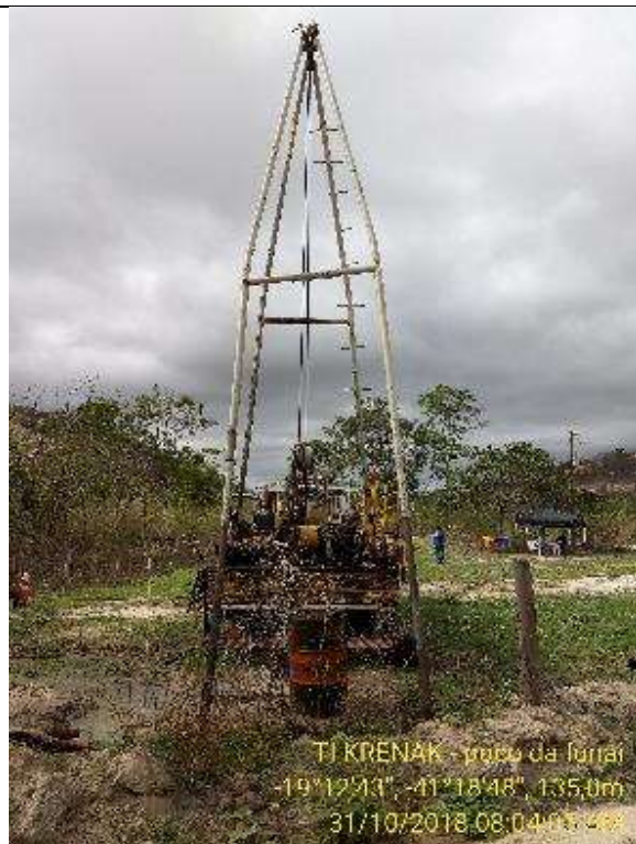
Figura 11- 2ª recuperação do poço da Funai
