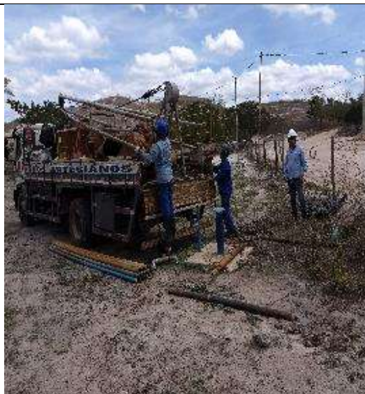
Figura 2- Poço da Funai- retirada da bomba para manutenção
