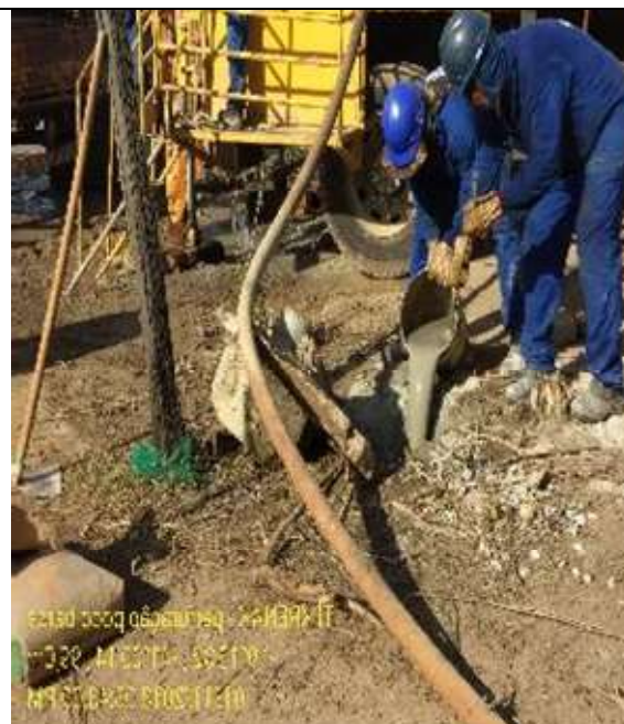
Figura 16- Tamponamento do antigo poço da Barca
