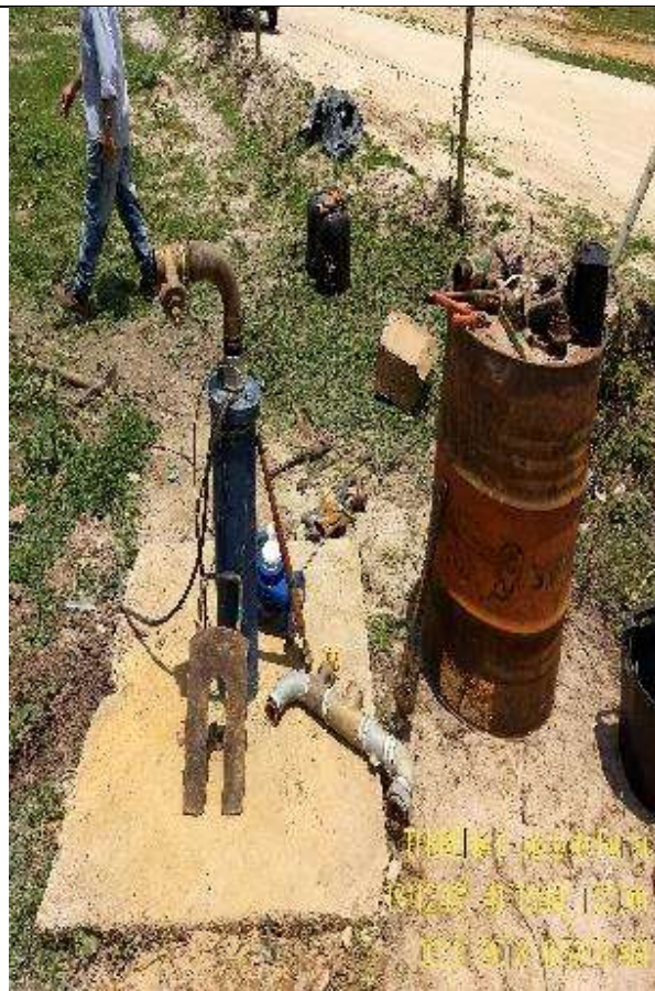
Figura 17- Finalização da 2ª recuperação do poço da Funai
