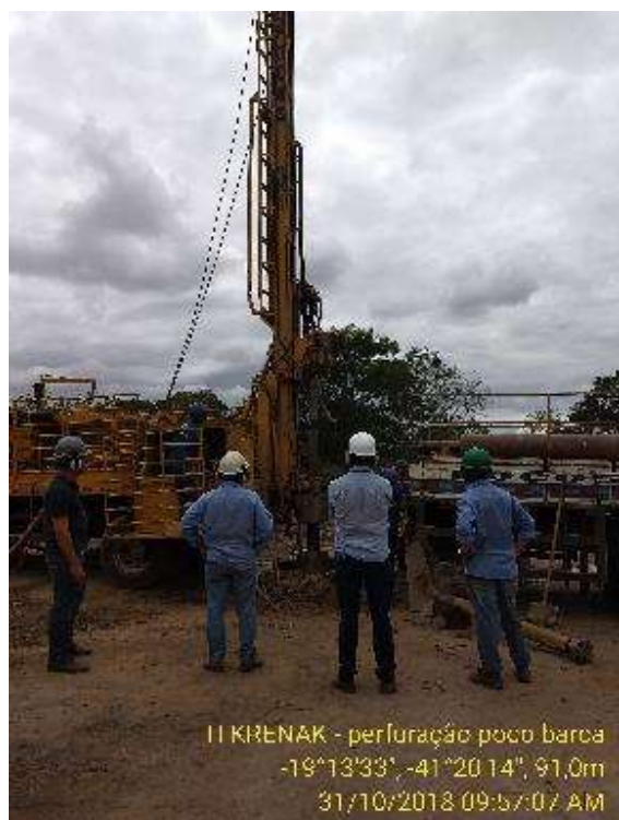
Figura 13- Perfuração do novo poço da Barca
