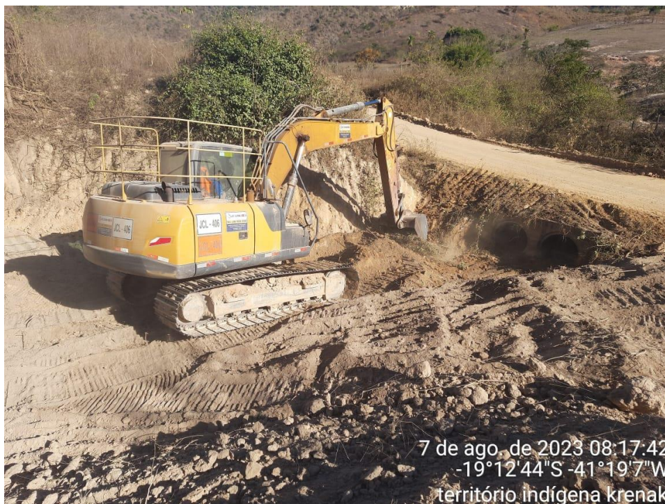
Figura 21 – Limpeza de Bueiros
