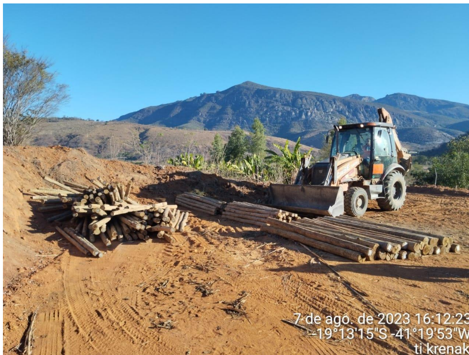
Figura 20 – Carregamento de Estacas
