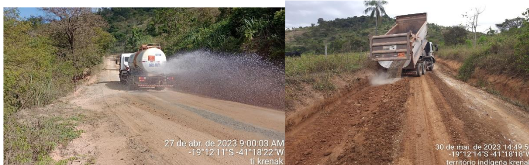
Figura 1 e 2 – Ações de manutenção de vias.
