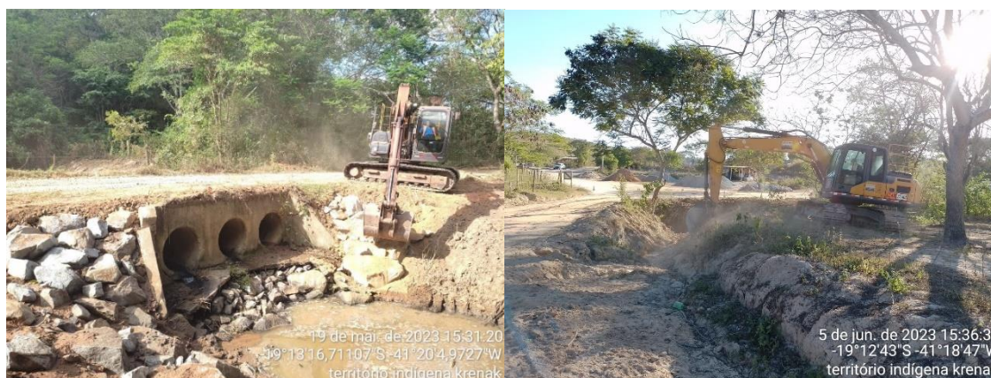
Figura 3 e 4 – Limpeza de bueiros.
