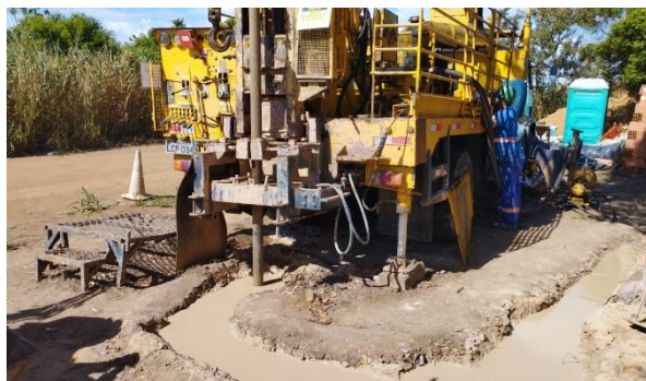
Figura 1 - Atividade de Perfuração do Poço na Comunidade de Córrego do Ouro, TI Comboios.
