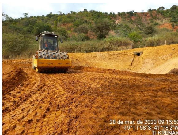
Figura 4 - Final da obra de contenção de erosão em uma das principais vias do TI Krenak.
