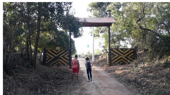
Figura 3.2.2.2-H – Instalação do Portal– Aldeia Olho D’Água.
