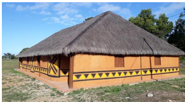
Figura 3.2.2.2-G – Instalação do Portal- Aldeia Olho D’Água.
