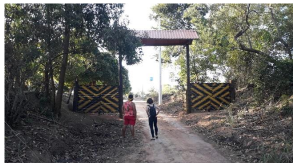
Figura 3.2.2.2-H – Instalação do Portal- Aldeia Olho D’Água.
