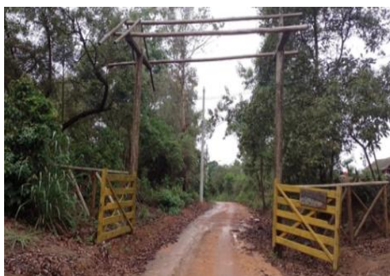
Fotografia 3.2.2.2-15 – Instalação do Portal– Aldeia Olho D'Água.
