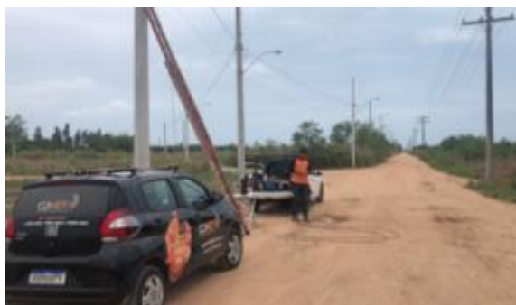
Fotografia 3.1.2.2-3 Instalação Ramal Internet
