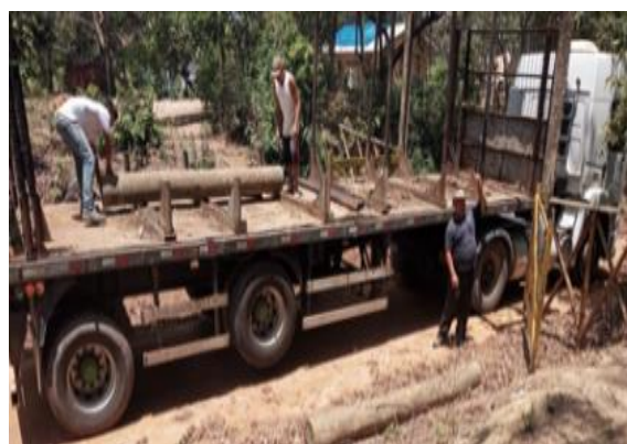
Fotografia 3.2.2.2-16 – Instalação do Portal– Aldeia Olho D'Água.
