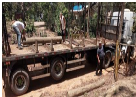
Fotografia 3.2.2.2-16 – Instalação do Portal– Aldeia Olho D'Água.
