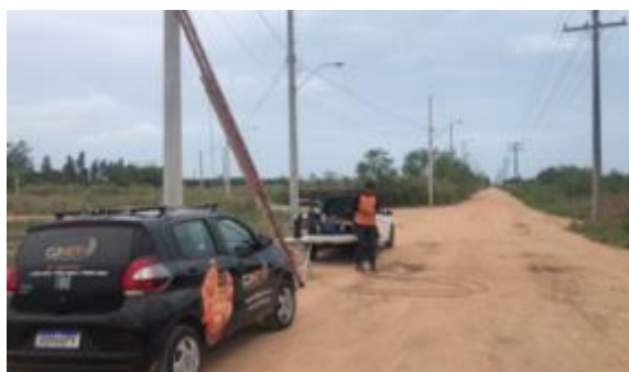
Fotografia 3.1.2.2-3 Instalação Ramal Internet
