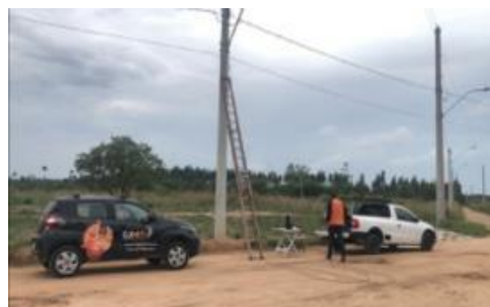
Fotografia 3.1.2.2-4 Instalação Ramal Internet
