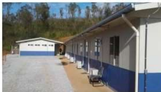
Foto Ambientação do Canteiro de Obras - Reassentamento Bento Rodrigues | julho/2018 (Crédito: Divulgação Fundação Renova)
