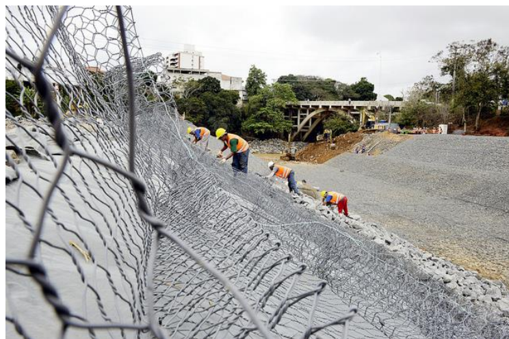
Figura 7: Obras de execução do colchão reno
