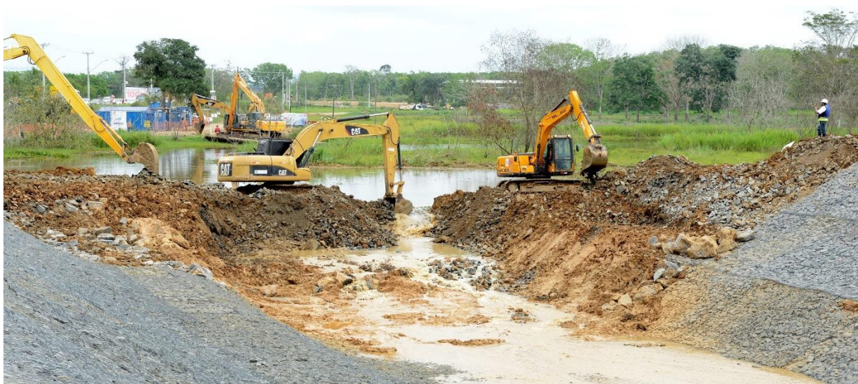
Figura 12: Continuação da abertura da ensecadeira, de maneira gradativa
