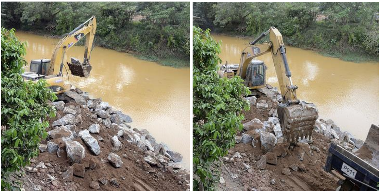
Figura 8: Obras de enrocamento com a utilização de matacos
