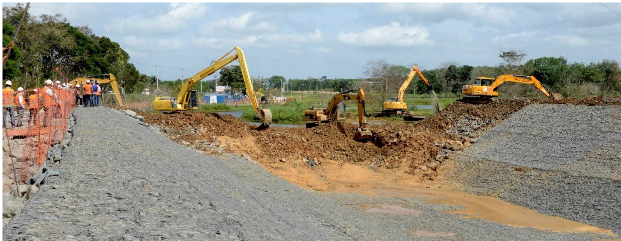
Figura 11: Abertura gradativa da ensecadeira
