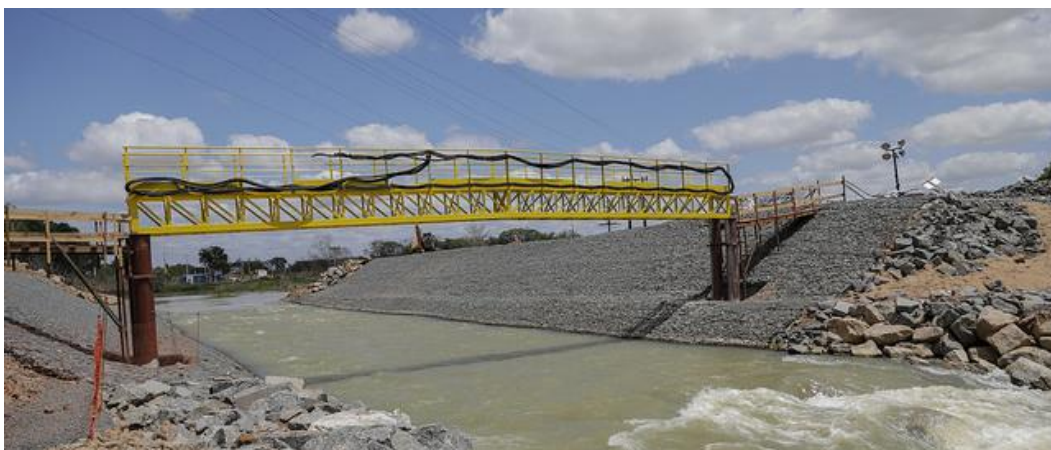
Figura 9: Passarela instalada permitindo acesso ao barramento com segurança
