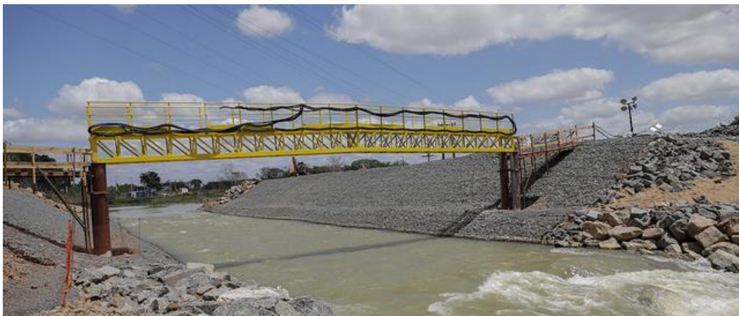
Figura 6: Passarela instalada permitindo acesso ao barramento com segurança
