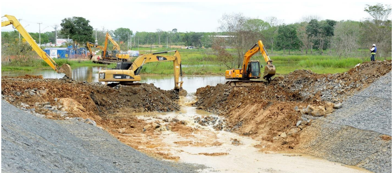
Figura 9: Continuação da abertura da ensecadeira, de maneira gradativa
