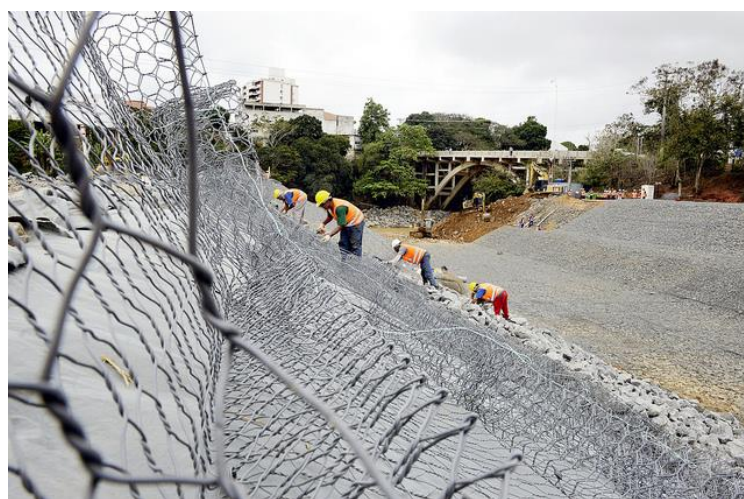
Figura 4: Obras de execução do colchão reno
