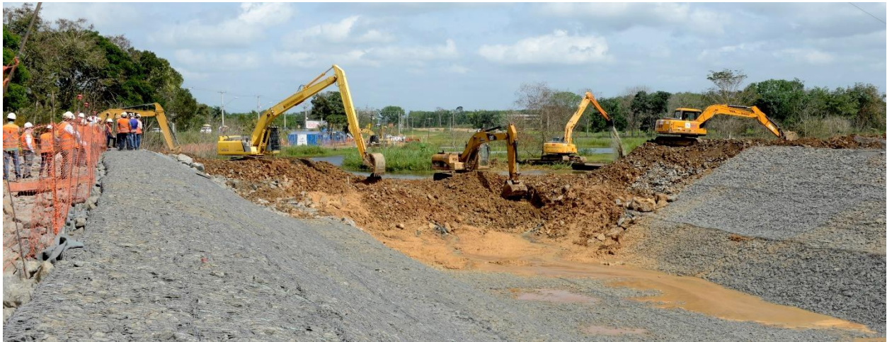
Figura 8: Abertura gradativa da ensecadeira
