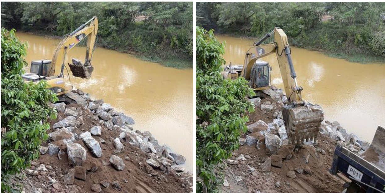
Figura 5: Obras de enrocamento com a utilização de matacos
