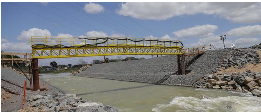
Figura 8: Passarela instalada permitindo acesso ao barramento com segurança
