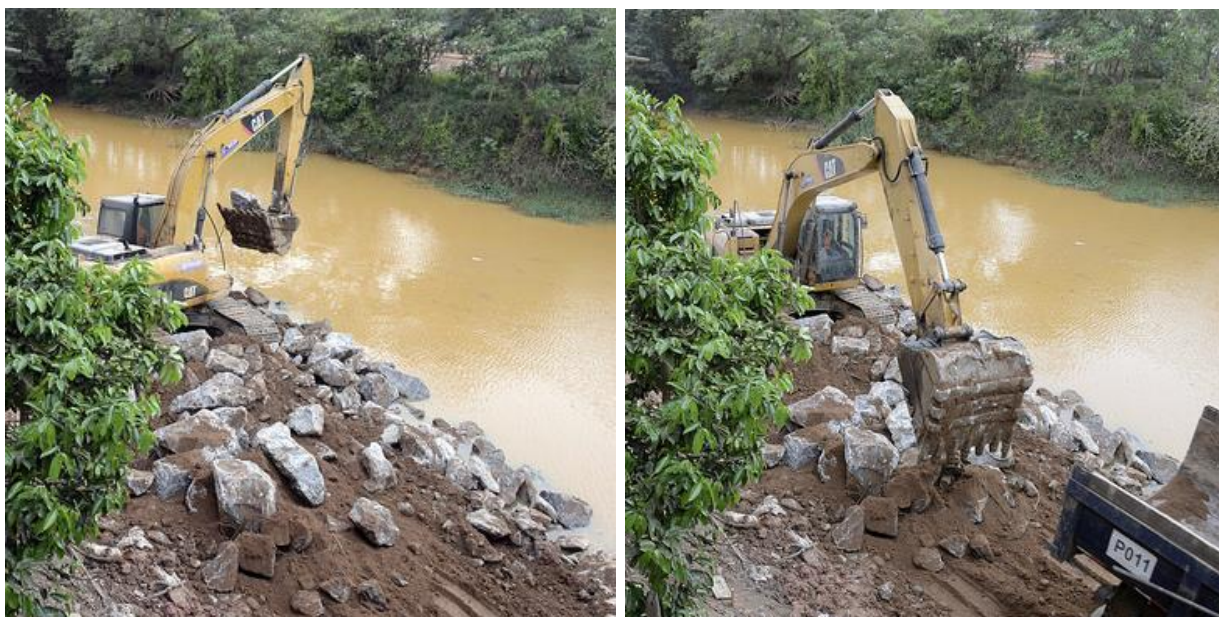
Figura 7: Obras de enrocamento com a utilização de matacos
