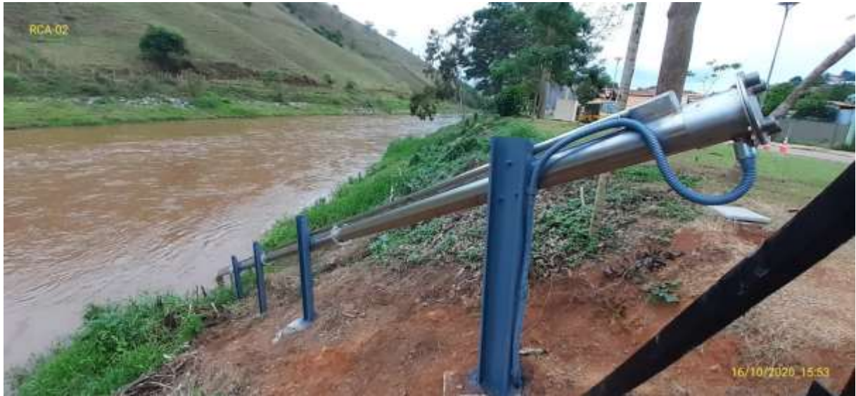
Figura 7- Sequência de fotos da nova estrutura da RDO 01 por diversos ângulos – Fotos de 16 e 28/10/2020
