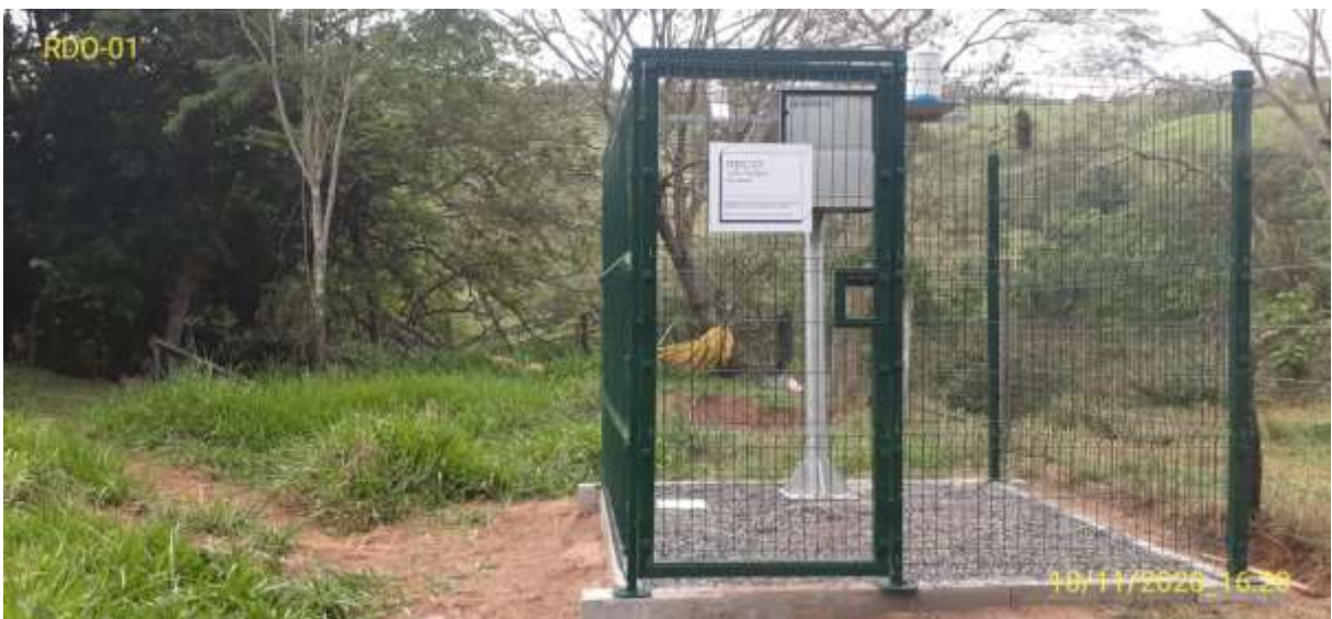
Figura 5 - Sequência de fotos da nova estrutura da RDO 01 por diversos ângulos – Fotos de 10/11/2020.
