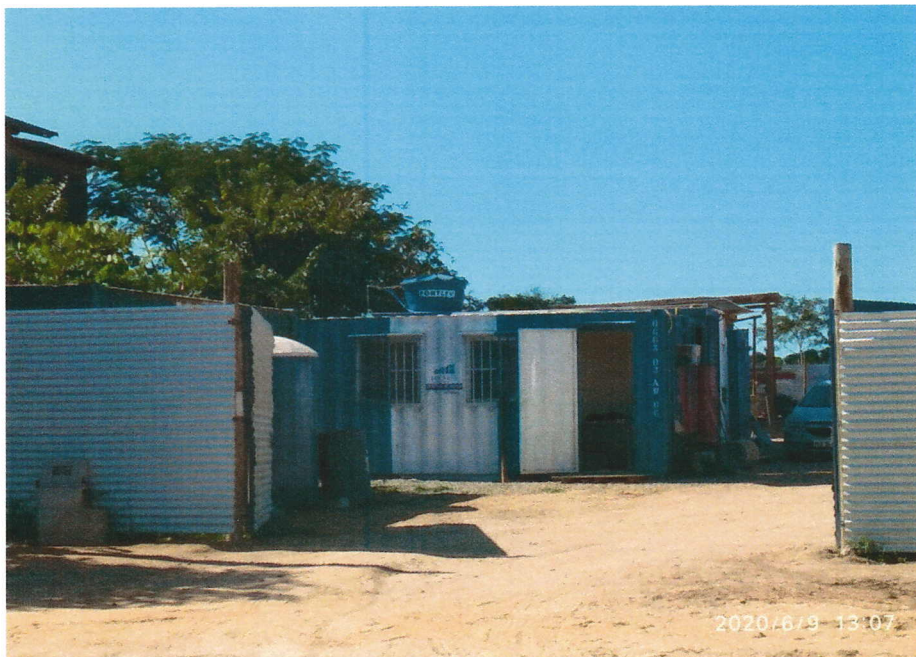
Foto 02: Canteiro de Obra
