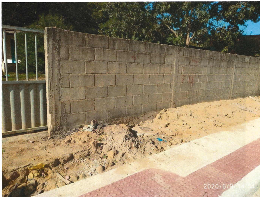
Foto 05: Ligação Predial de Esgoto – Av. Principal
