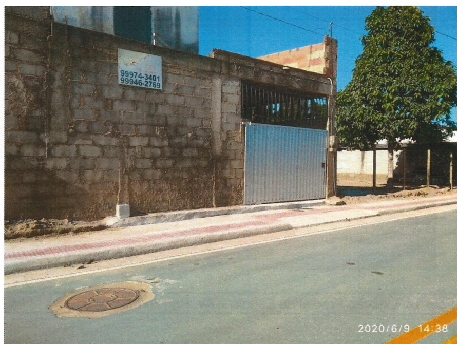
Foto 12: Ligação Predial de Esgoto e Poço de Visita – Av. Principal
