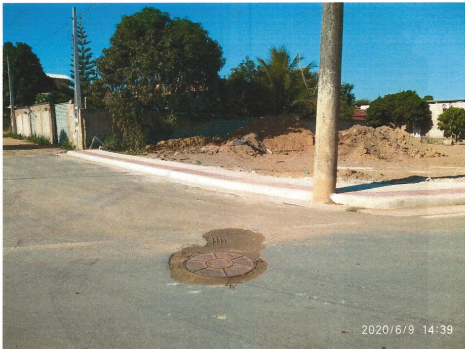
Foto 04: Poço de Visita – Av. Principal
