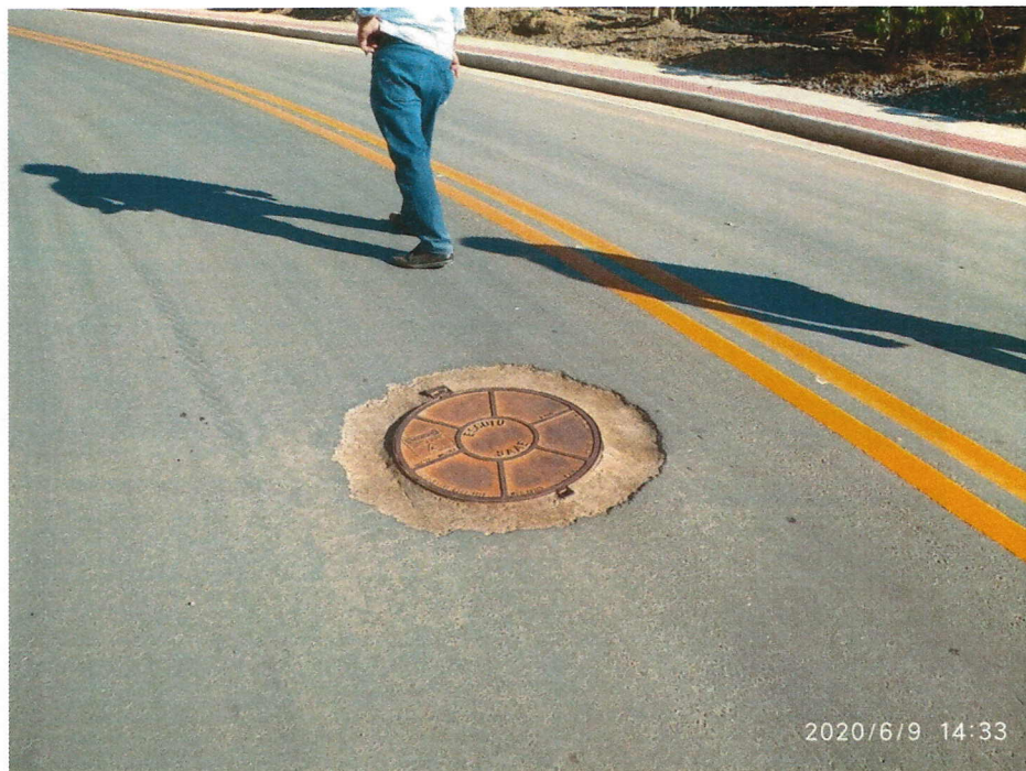
Foto 07: Poço de Visita – Av. Principal
