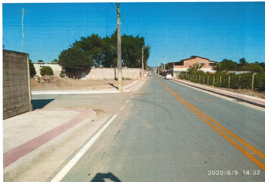
Foto 13: Poço de Visita – Av. Principal
