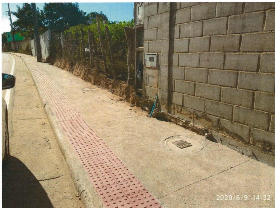
Foto 06: Ligação Predial de Esgoto – Av. Principal
