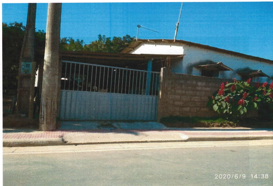
Foto 14: Ligação Predial de Esgoto – Av. Principal
