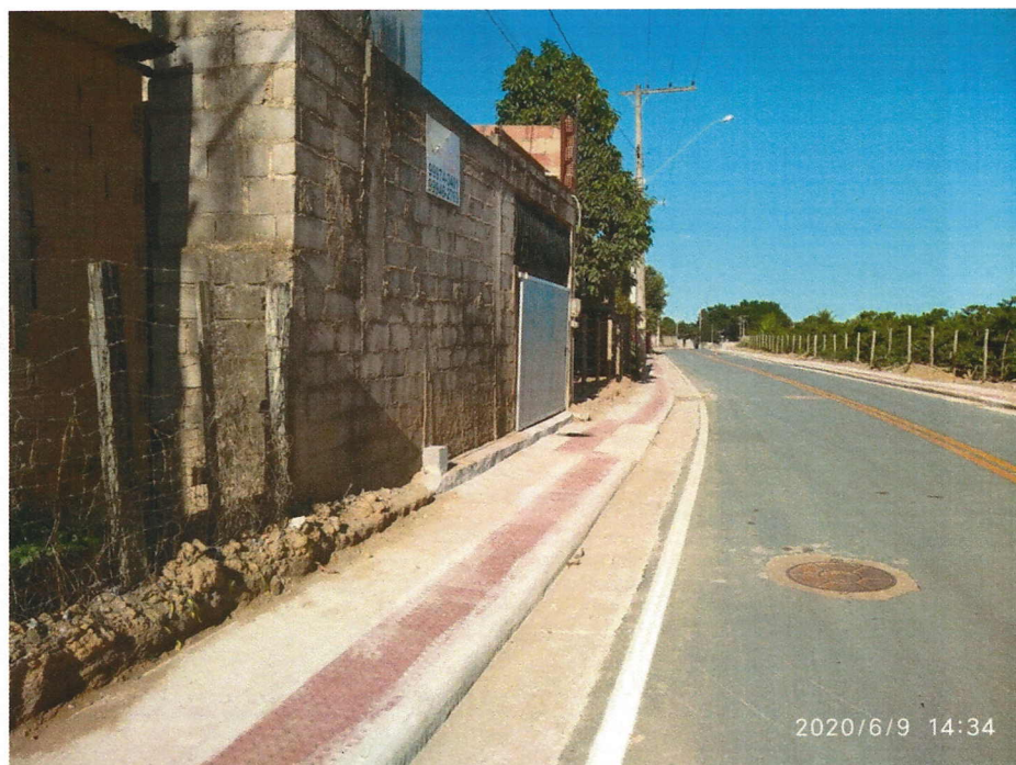
Foto 08: Poço de Visita – Av. Principal
