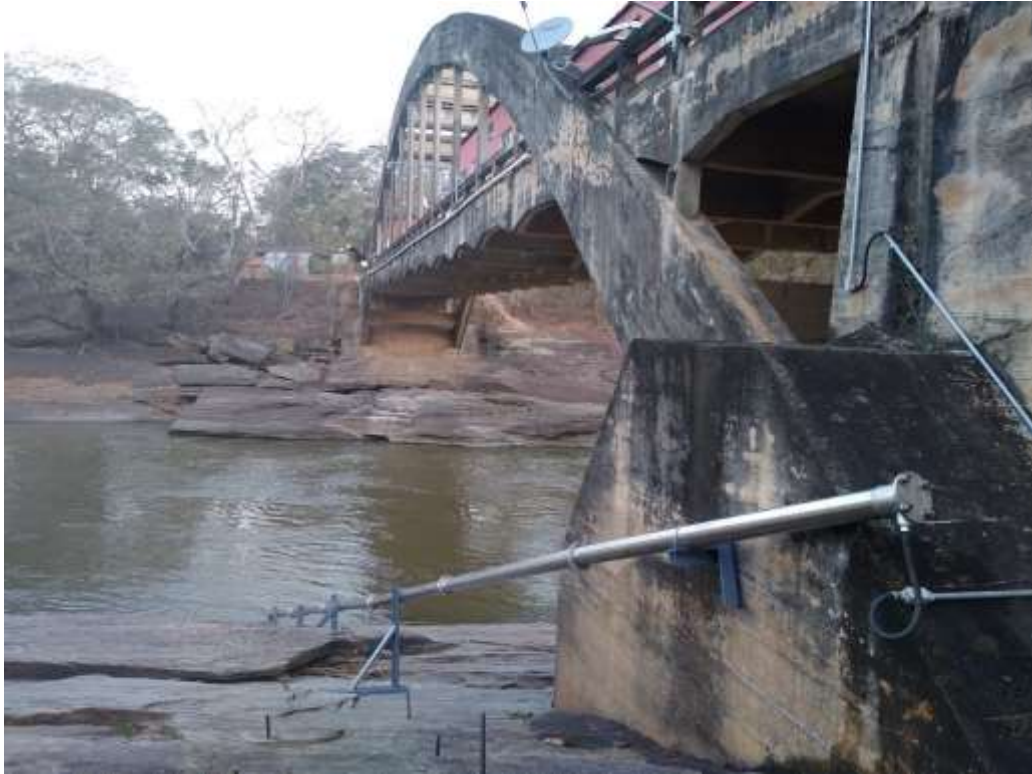
Figura 2 - Sequência de fotos da nova estrutura da RDO 04 por diversos ângulos – Fotos de 30/09/2020.
