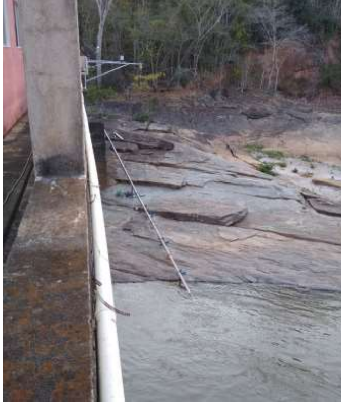
Figura 3 - Sequência de fotos da nova estrutura da RDO 04 por diversos ângulos – Fotos de 30/09/2020.v(continuação)
