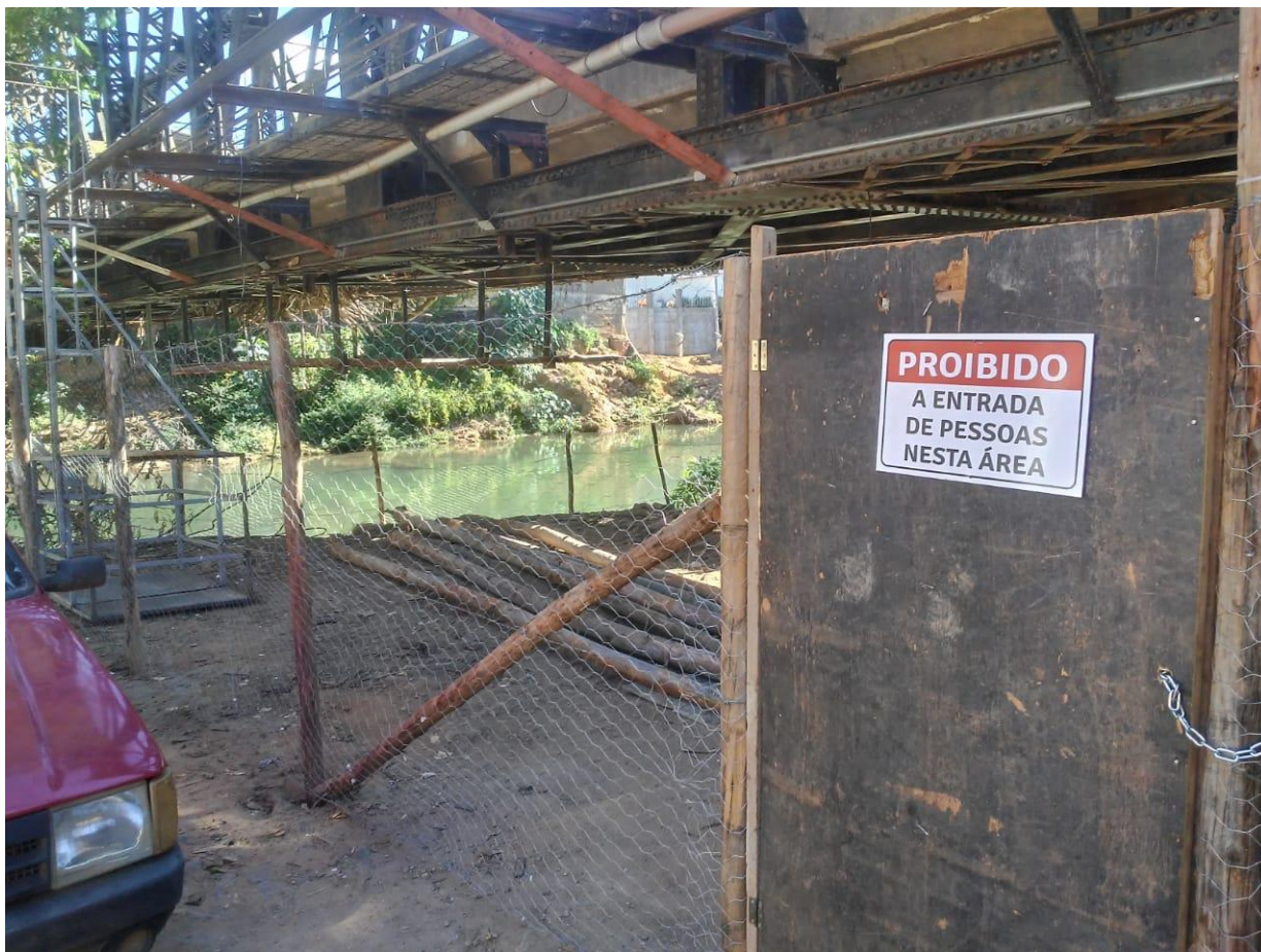
Foto 01: Cercamento devido a obras da prefeitura no ponto de acesso ao RMA-01 – Raul Soares/MG
