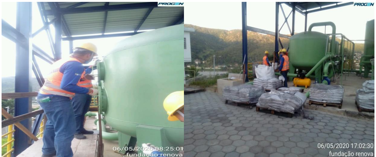
Figura 2 – Troca do material do Filtro STARF
