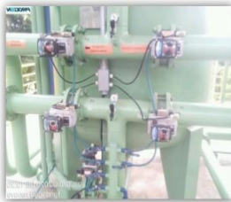
Conferindo os fechamentos das válvulas
