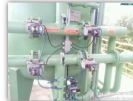
Conferindo as válvulas pneumáticas
