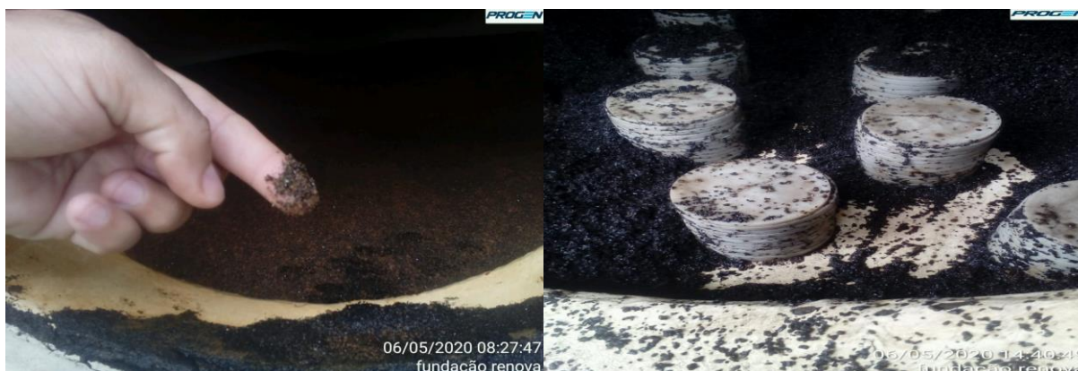
Figura 3 – Material filtrante (à esquerda) e crepinas do Filtro STARF (à direita)
