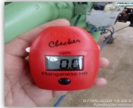
Teste de manganês após a troca do zeólito no filtro STARF
