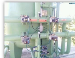
Conferindo as válvulas pneumáticas
