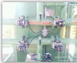
Conferindo as aberturas e fechamentos de válvulas
