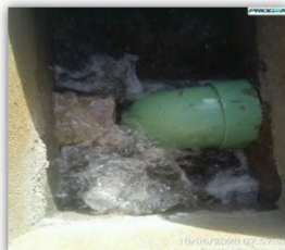
Iniciando a retrolavagem do filtro STARF
