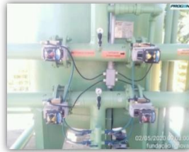
Conferindo as aberturas e fechamentos de válvulas
