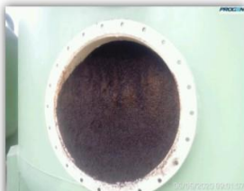
Iniciando a retirada da janela de visita na parte inferior do filtro
