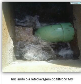
Iniciando a retrolavagem do filtro STARF
