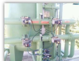
Conferindo as válvulas pneumáticas
