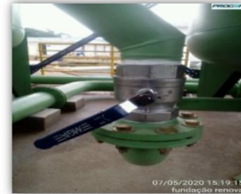
Ajustado o posicionamento da válvula esférica para o Blend com 10 l/s
