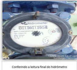
Conferindo a leitura final do hidrômetro
