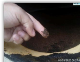
Retirando a janela de visita na parte superior do filtro e conferindo a areia zeólita
