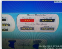
Sistema automático com uma vazão de 28 l/s
