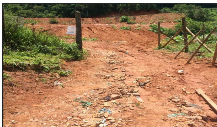
Foto 10: Vista do acesso aterro de Barra Longa.
