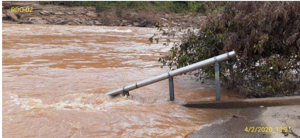
Figura 13 - Tubo de proteção da sonda na RDO 02 que resistiu ao evento de cheia.
