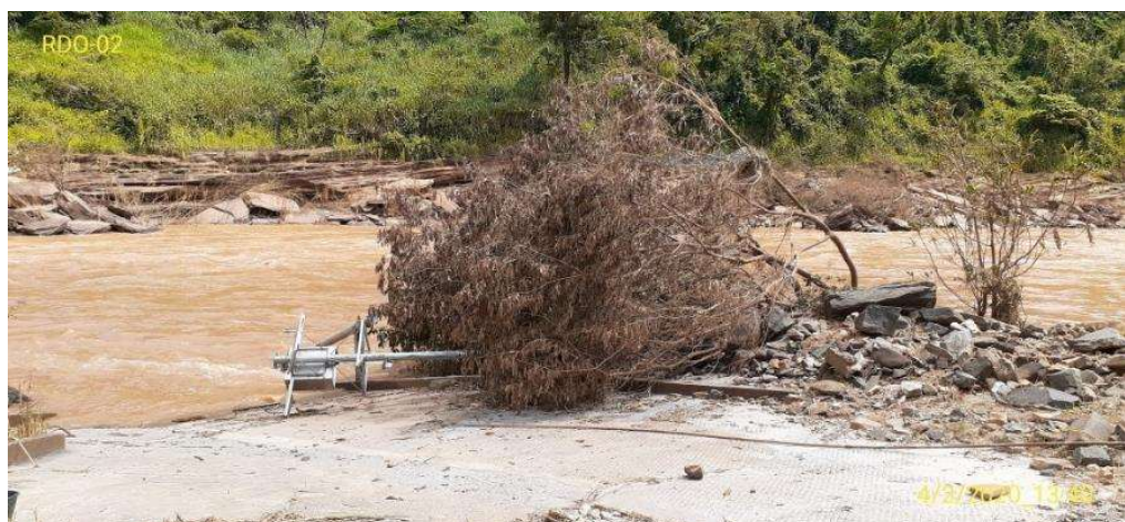
Figura 12- Poste da RDO 02 derrubado pela força da água.
