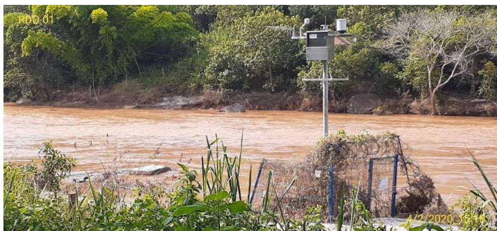
Figura 8 - Estação RDO 01 em 04/02/2020 - detalhe do gradil da PCD danificado.
