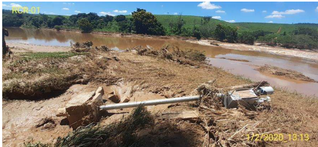
Figura 22 - Estação RCR 01 em 01/02/2020, danificada pela cheia do dia 30/01/2020.
