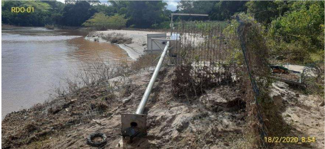
Figura 9 - Equipamentos da RDO 01 sendo desmobilizados.
