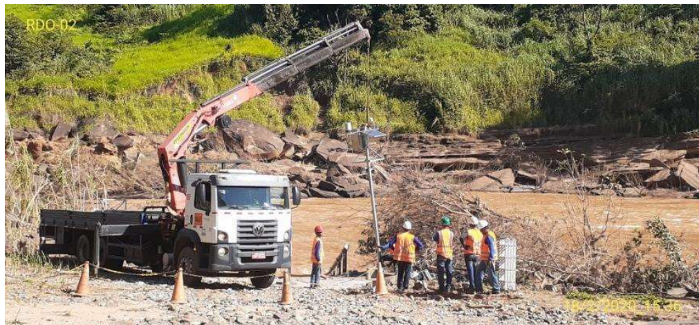
Figura 14 - Instalação do poste da RDO 02 para retomada das transmissões.
