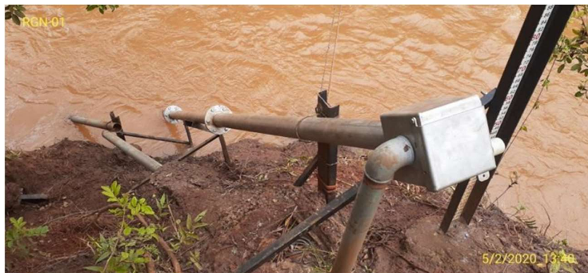
Figura 2 - Estação RGN 01 em 05/02/2020 após manutenção.
