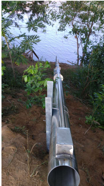
Figura 4- Tubulação em padrão mais resistente instalada na RDO 03.
