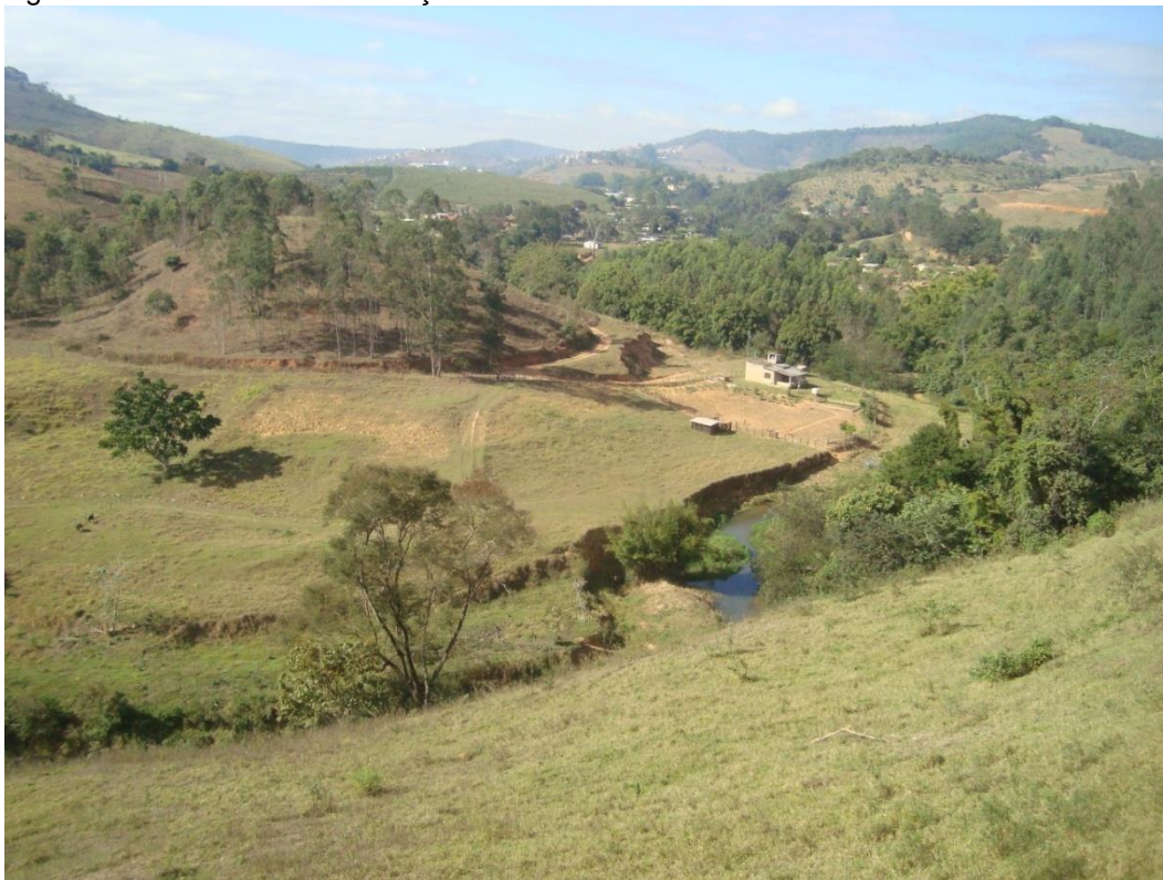
Figura 3.1: Vista local da instalação da nova ETE Centro – Rio Prata.
