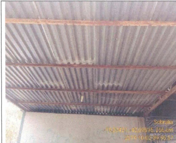
17. Estrutura da cobertura (02/10/19)
