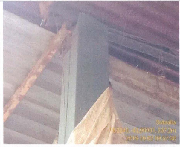
18. Estrutura da cobertura (02/10/19)
