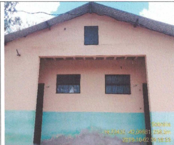
29. Vista dos fundos da unidade de apoio onde ficam os banheiros (02/10/19)
