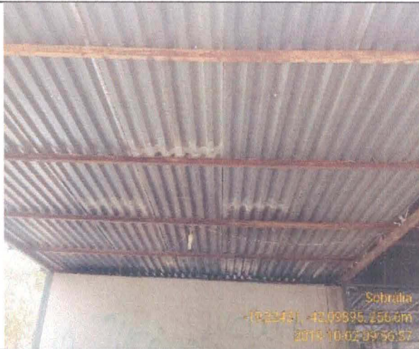
17. Estrutura da cobertura (02/10/19)
