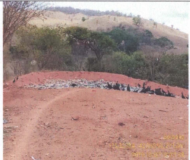
20. Vala de resíduos (02/10/19)
