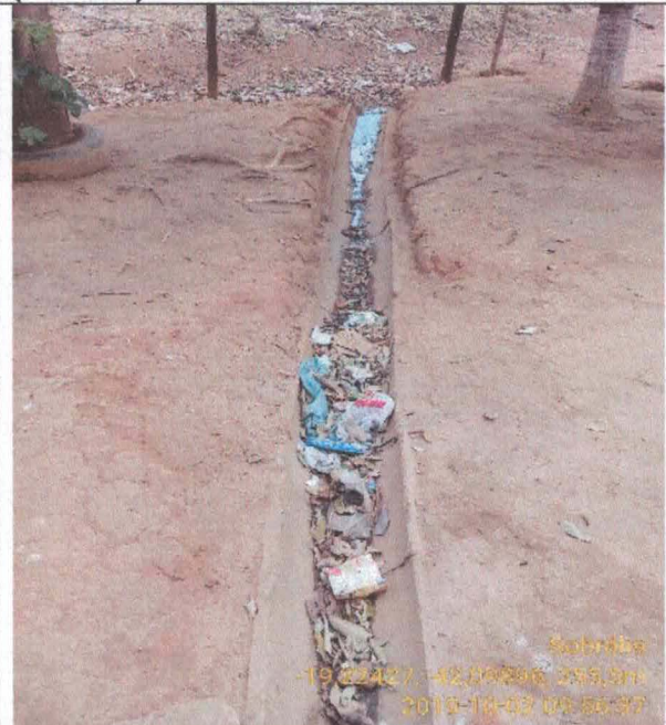
16. Canaleta de drenagem pluvial - obstruída (02/10/19)
