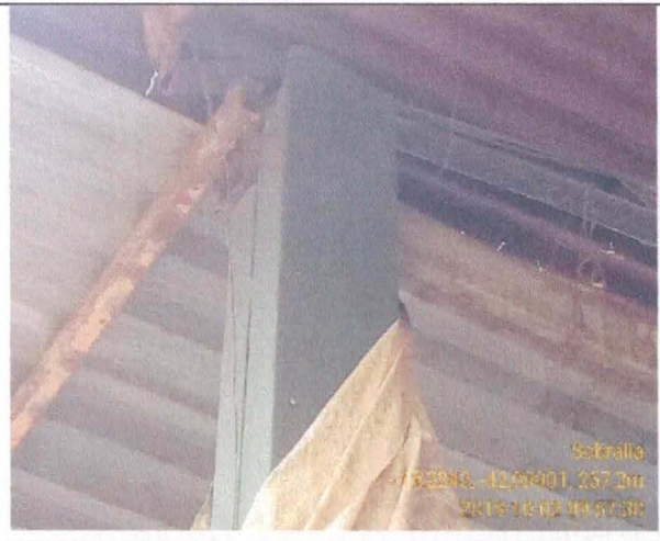
18. Estrutura da cobertura (02/10/19)
