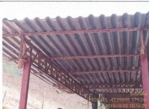
36. Detalhe da cobertura em processo de ferrugem (02/10/19)
