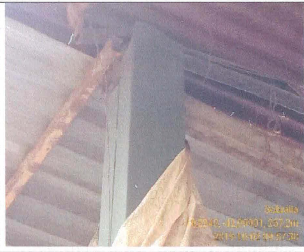
18. Estrutura da cobertura (02/10/19)
