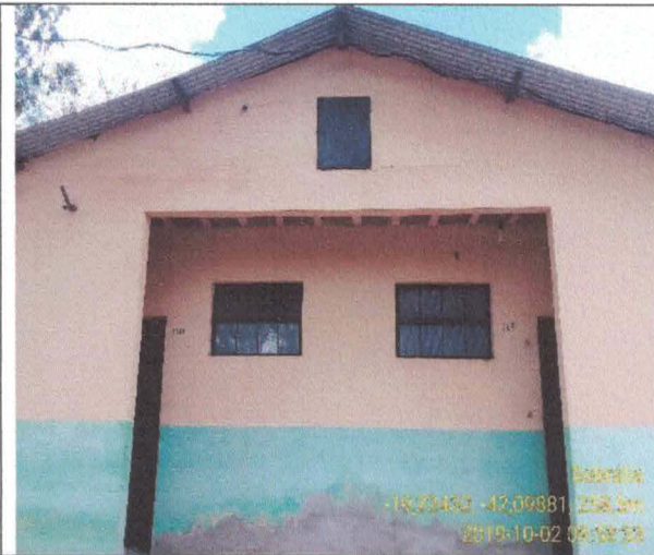
29. Vista dos fundos da unidade de apoio onde ficam os banheiros (02/10/19)
