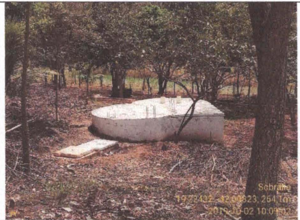
26. Sistema de tratamento do esgoto doméstico (02/10/19)
