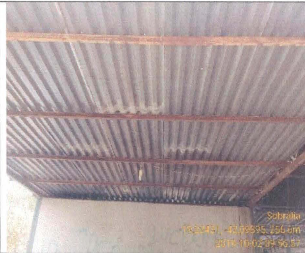
17. Estrutura da cobertura (02/10/19)
