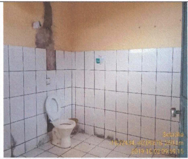
30. Vista de um dos banheiros (02/10/19)
