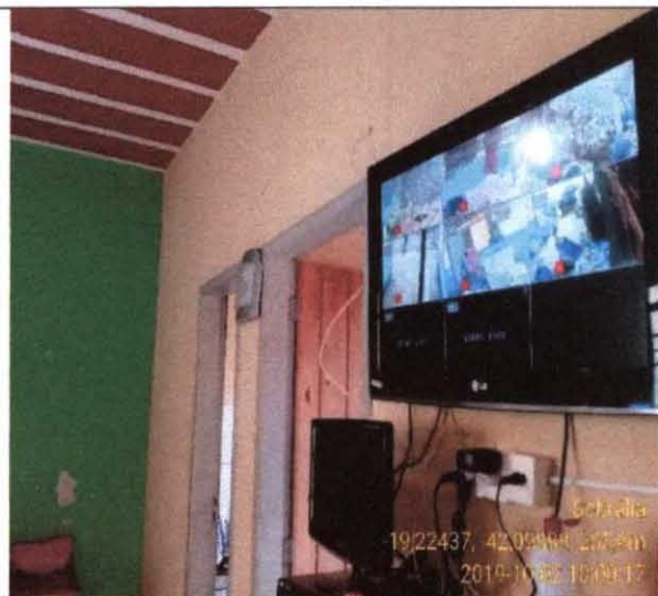
32. Vista da sala (02/10/19)
