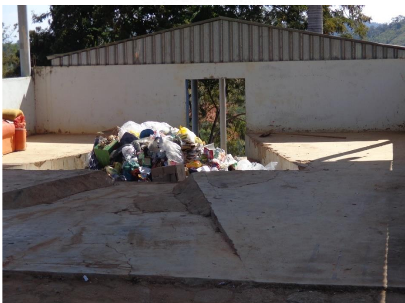
Figura 13: Moega de recepção do lixo coletado.
