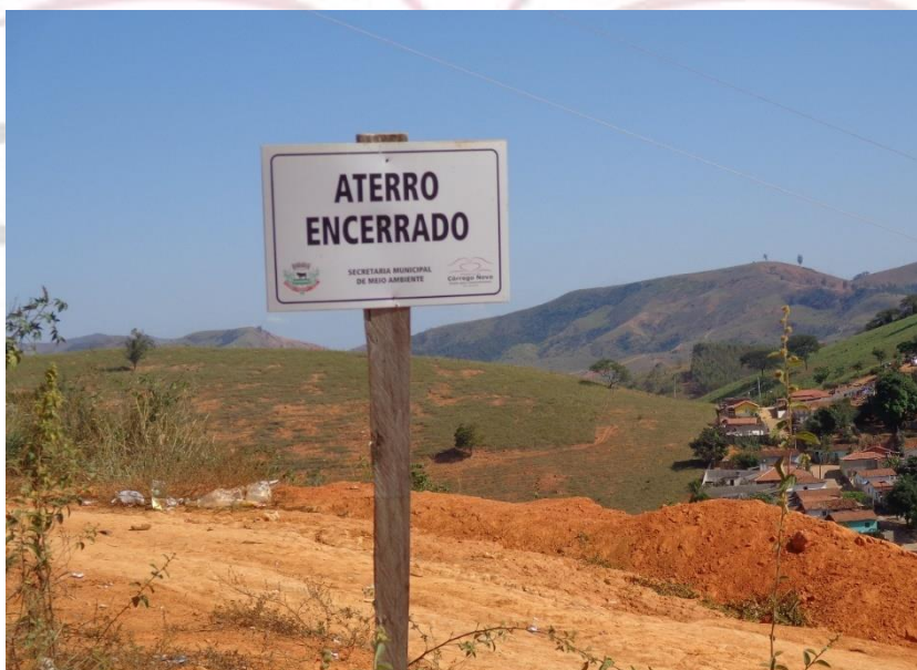
Figura 17: aterro de materiais não passíveis de utilização/rejeitos.
