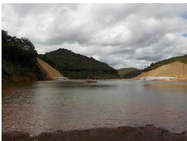
Figura 75: Vista panorâmica do reservatório do Dique S4 (fotografia retirada de montante para jusante).
