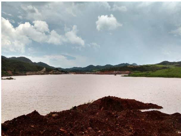
Figura 1: Vista panorâmica do Dique S3. Fotografia realizada de montante para jusante.
