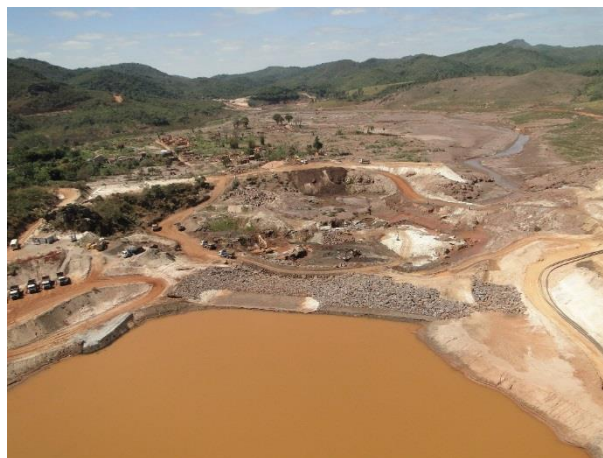
Figura 1.3: Vista panorâmica (W-E) do Dique S3, com Bento Rodrigues ao fundo (25 de agosto de 2016).
