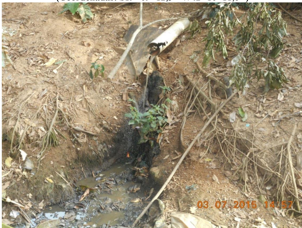
Figura 45: Lançamento de esgoto doméstico in natura no Distrito de Plautino Soares (Coordenadas: S19° 09’ 12,3” W42° 10’ 11,6”)
