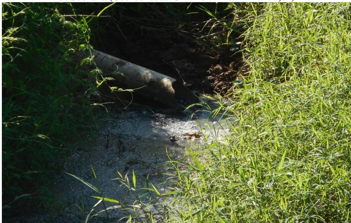
Figura 43: Ponto de lançamento de esgoto doméstico in natura da rede coletora na sede de Sobrália (Coordenadas: S 19°13'59" W 42° 05'57,6")
