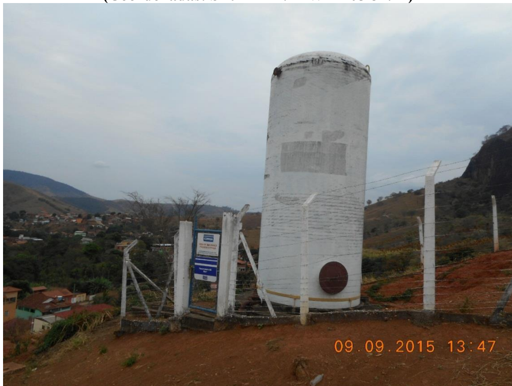
Figura 34: Reservatório REL 02 (Coordenadas: S 19°14'24.2" W 42°05'37.4")
