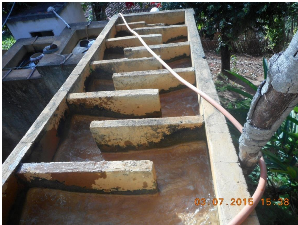
Figura 37: Estação de Tratamento de Água (Coordenadas: S19°09'03.0" W42°09'52,1")
