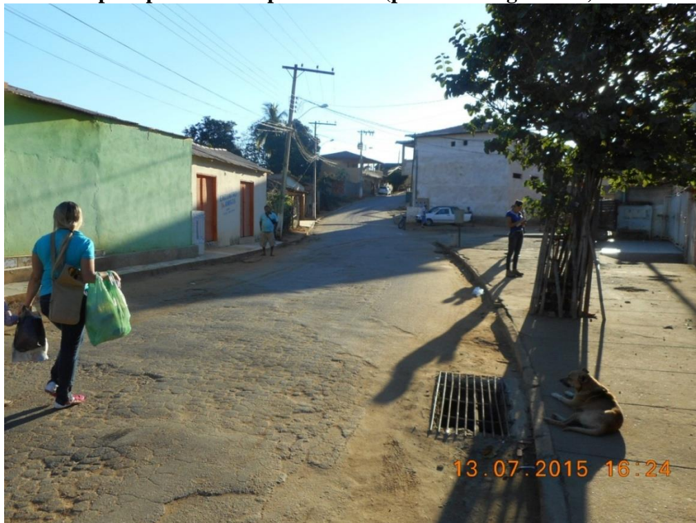
Figura 53: Área central na cidade de Sobralia sem drenagem pluvial onde toda água precipitada escoou pela mesma (ponto de alagamento).
