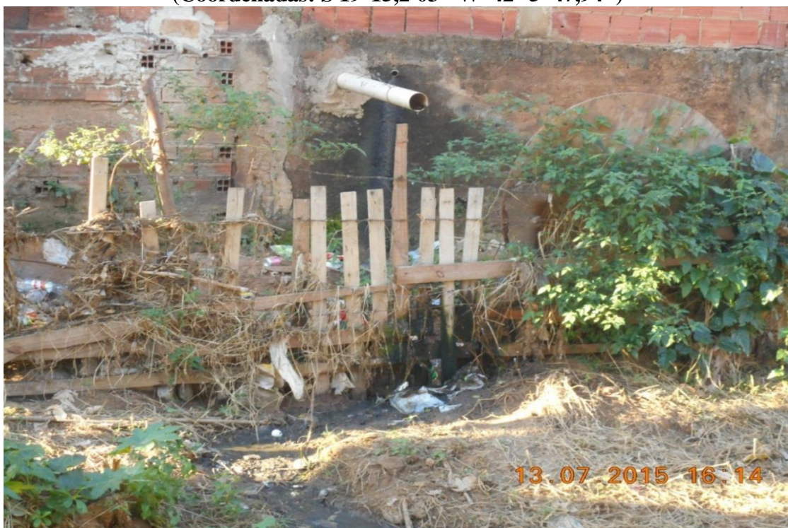
Figura 41: Ponto de lançamento de esgoto doméstico in natura na sede de Sobralia (Coordenadas: S 19°15,2'03" W 42° 5' 47,94")
