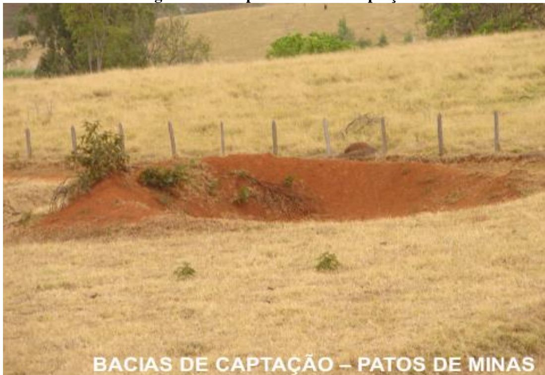
Figura 3: Exemplo de Bacia de captação
