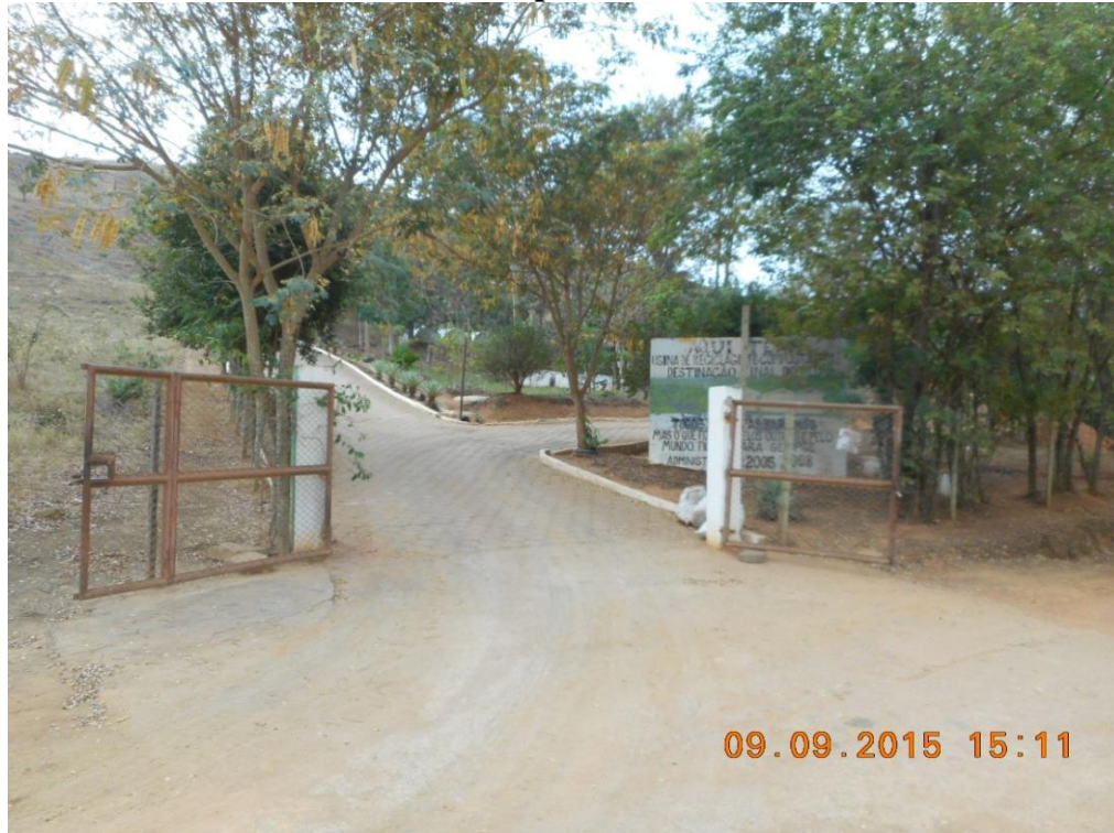
Figura 75: Entrada da UTC de Sobrália, com placa informativa e portão para controle de entrada de pessoas e veículos.
