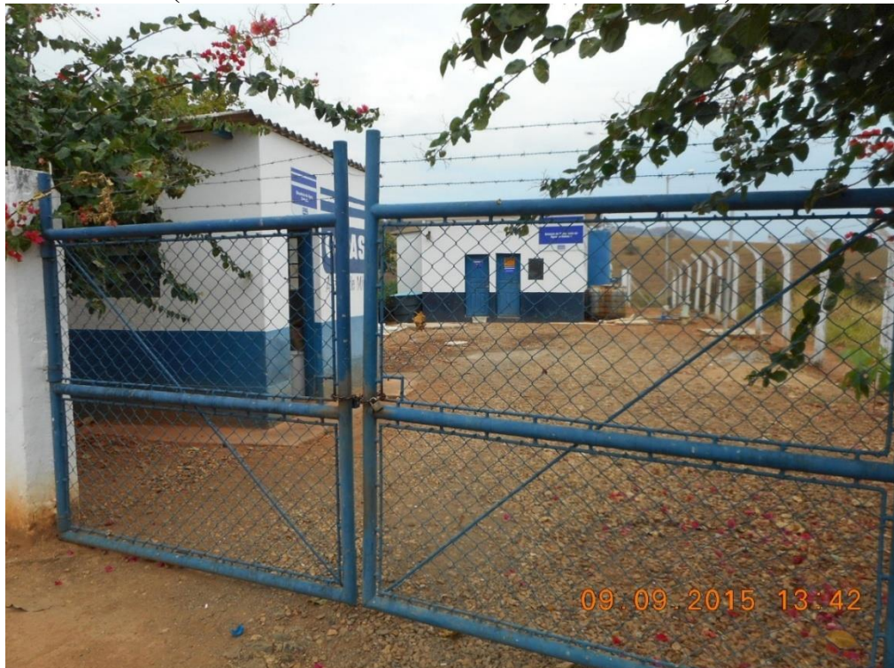
Figura 50: Visão frontal da ETA de Sobrália (Coordenadas: S 19° 14' 22.8" W 42°05' 39.3")
