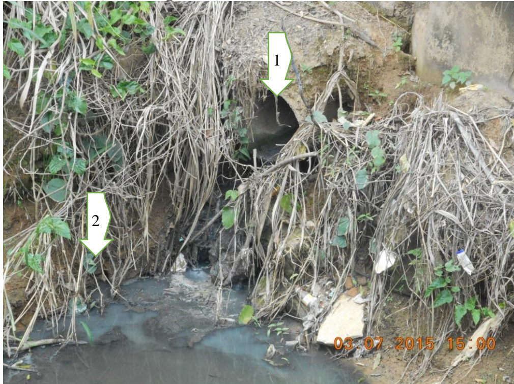
Figura 104: Cenário ilustrando a chegada das redes de esgoto (1) drenagem (1) no Sistema Fluvial, com carga de sedimentos (2) oriundo das áreas de montante
