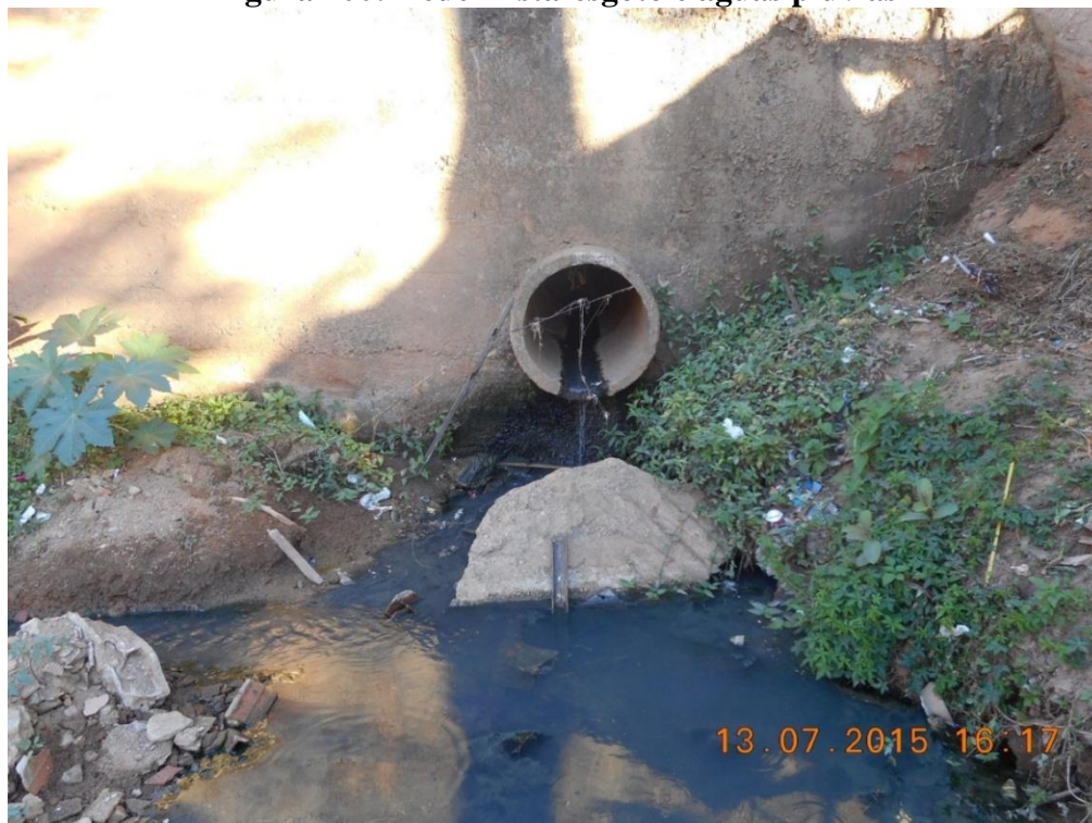
Figura 100: Rede mista-esgoto e águas pluvias
