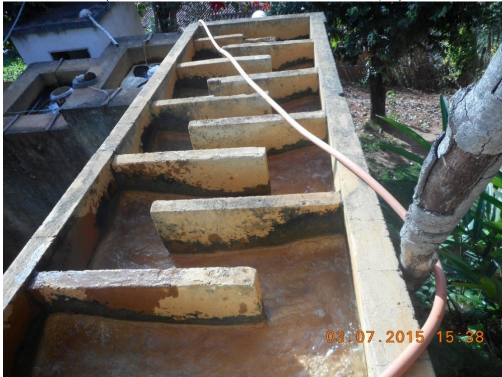
Figura 55: Estação de Tratamento de Água (Coordenadas: S19°09'03.0" W42°09'52,1")
