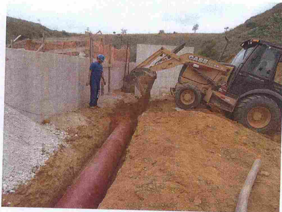
FOTO 9 – Vista do reaterro dos tubos de interligações do sistema Ø600 mm
