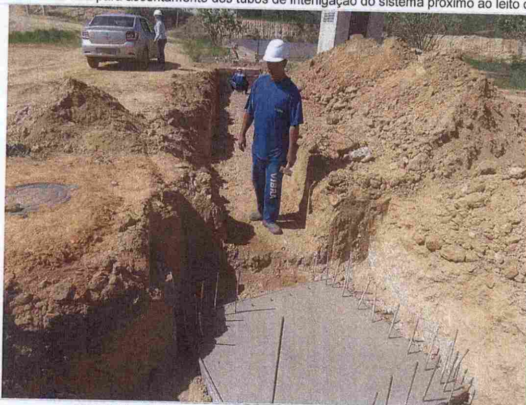
FOTO 14 – Vista do preparo do PV próximo ao leito de secagem
