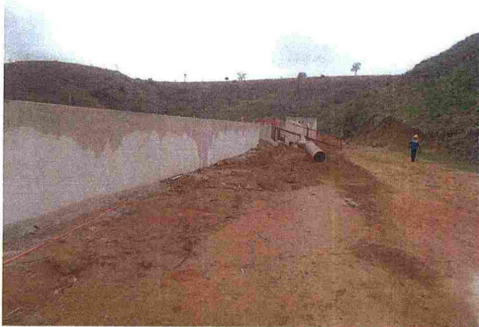
FOTO 3 – Vista do preparo para assentamento dos tubos de interligações do sistema Ø600 mm..
