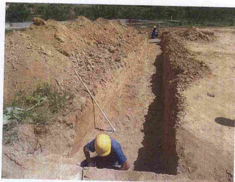
FOTO 13 – Vista da vala para assentamento dos tubos de interligação do sistema próximo ao leito de secagem
