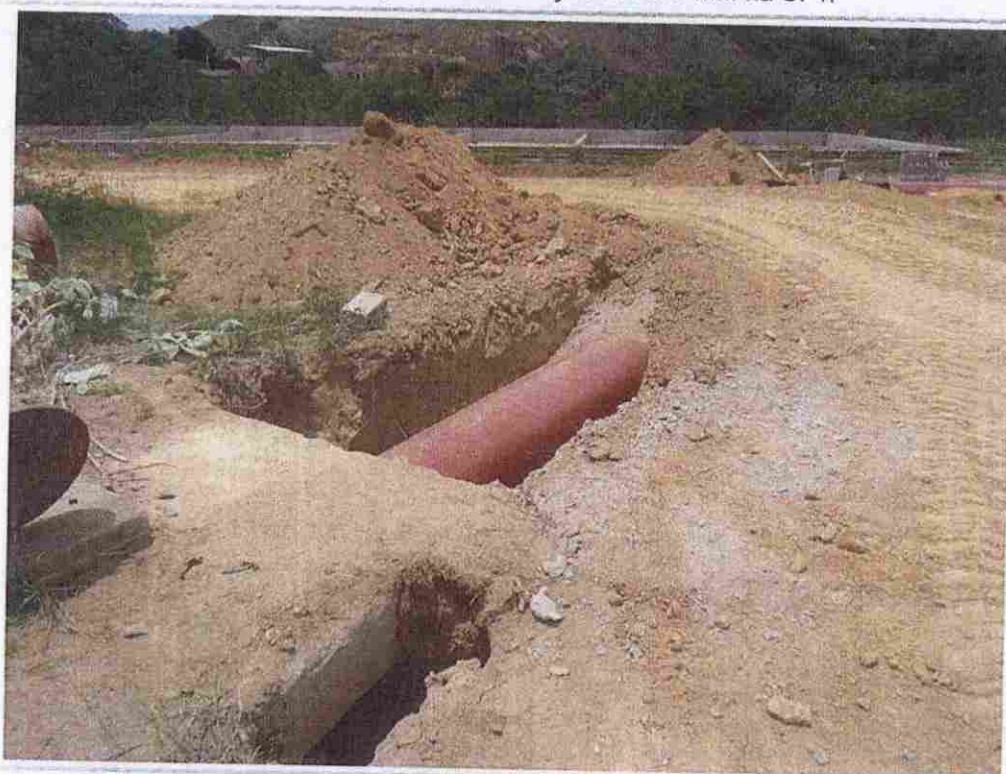
FOTO 18 – Vista da tubulação assentada próximo a Câmara de Contato
