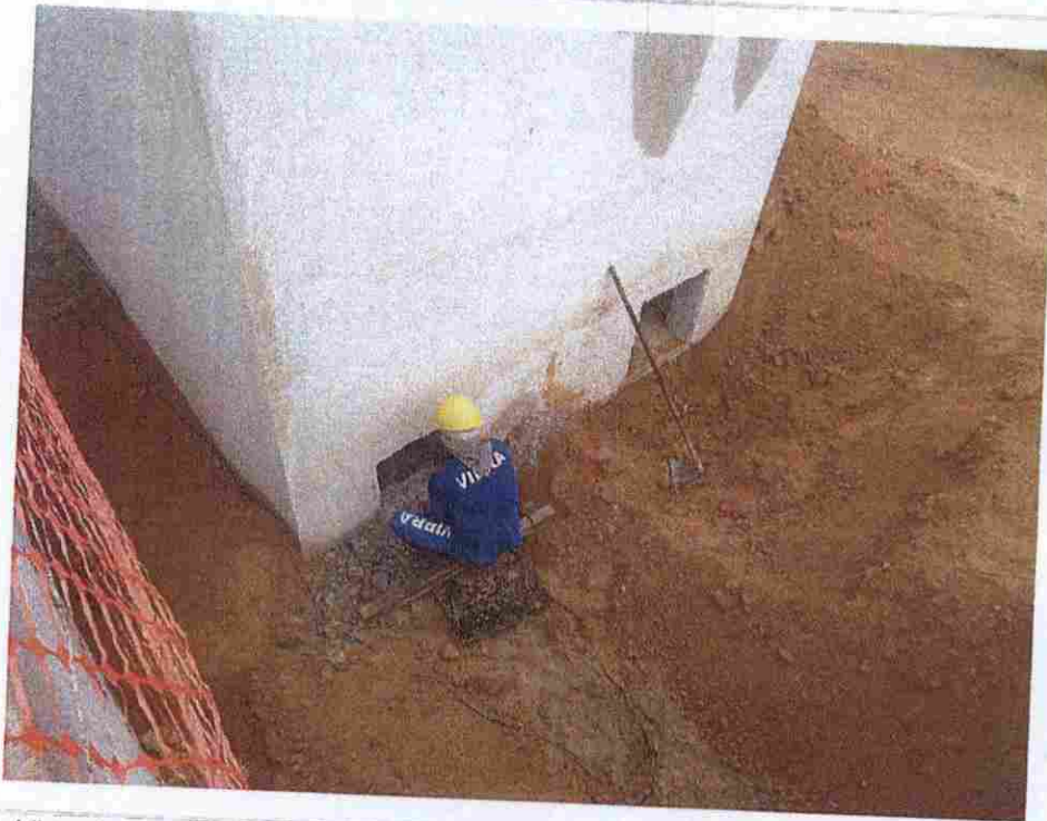
FOTO 1 – Vista da preparação da CF 1 para assentamento da tubulação de interligação do sistema
