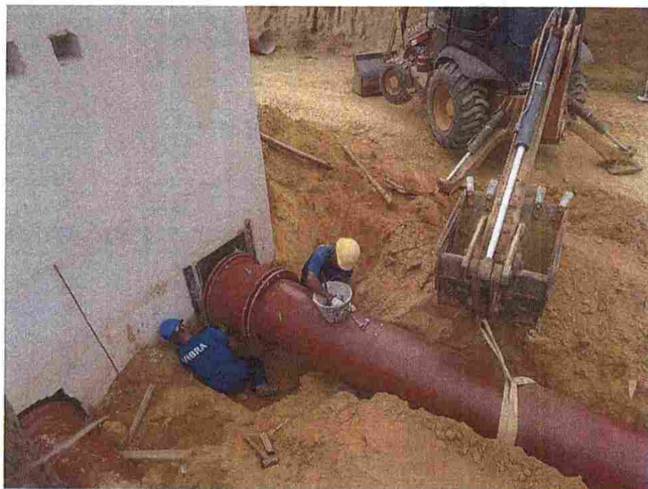
FOTO 12 – Vista do assentamento dos tubos de interligações do sistema Ø600 mm
