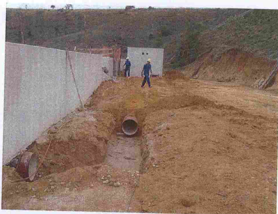
FOTO 10 – Vista do reaterro dos tubos de interligações do sistema Ø600 mm
