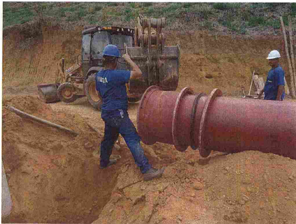
FOTO 11 – Vista do assentamento dos tubos de interligações do sistema Ø600 mm
