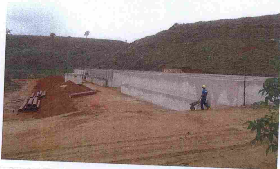
FOTO 2 – Vista da tubulação de interligação do sistema
