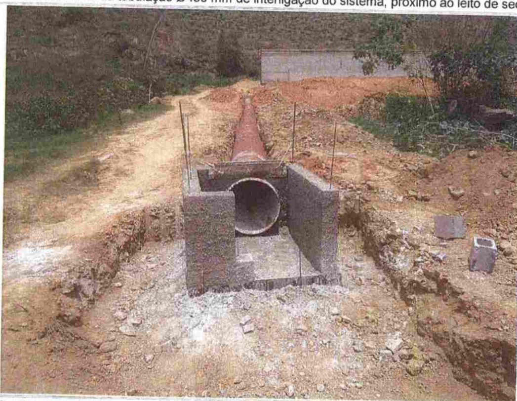
FOTO 20 – Tubulação Ø450 mm de interligação do sistema, já assentada, próximo ao leito de secagem.
