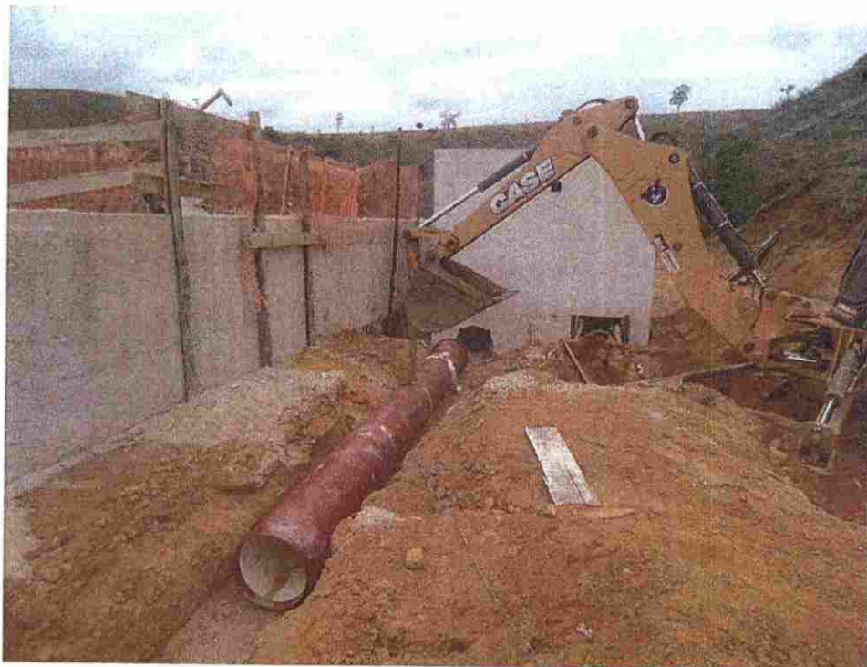
FOTO 7 – Vista do assentamento dos tubos de interligações do sistema Ø600 mm
