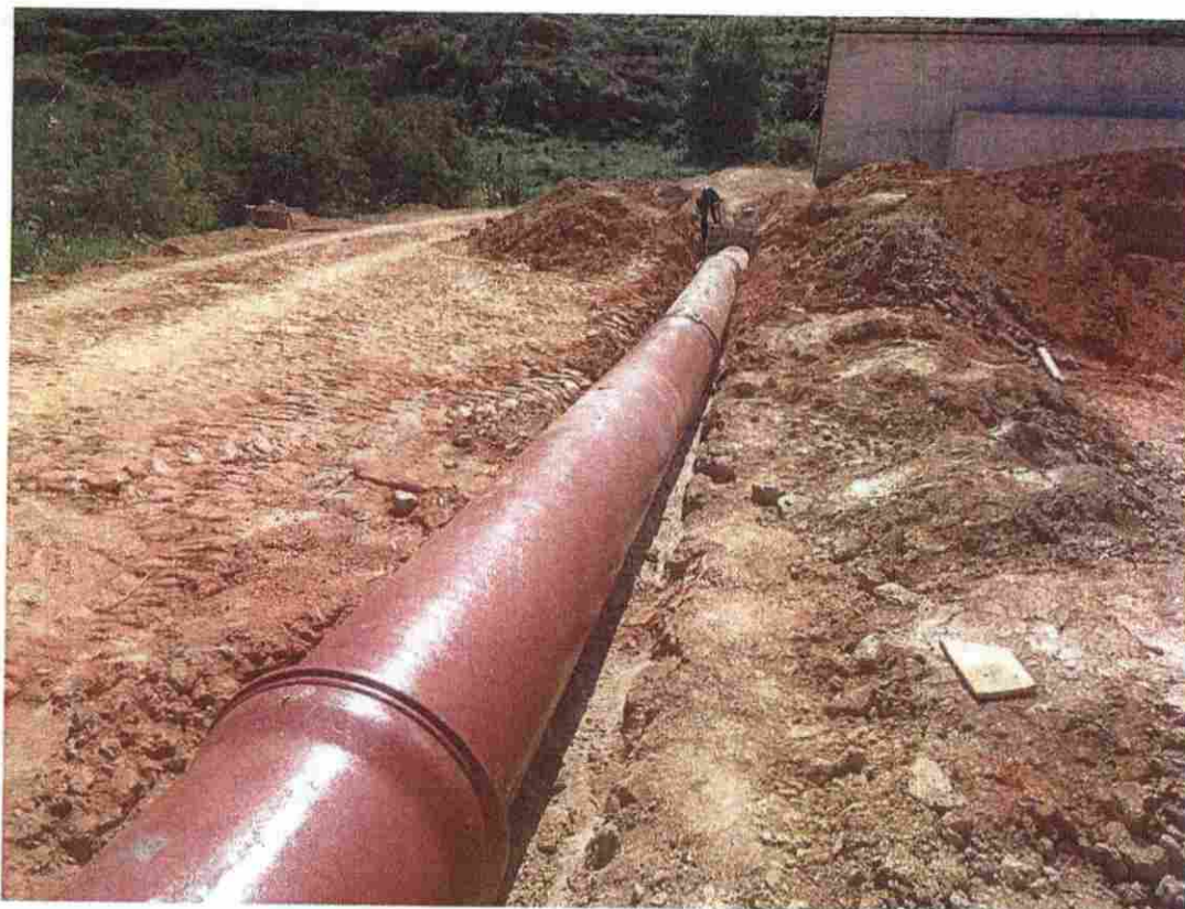
FOTO 15 – Vista da tubulação assentada após os reatores e a CF2
