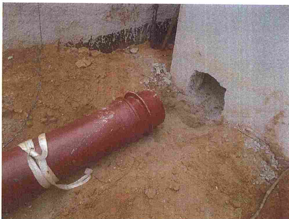
FOTO 8 – Vista do assentamento dos tubos de interligações do sistema Ø600 mm
